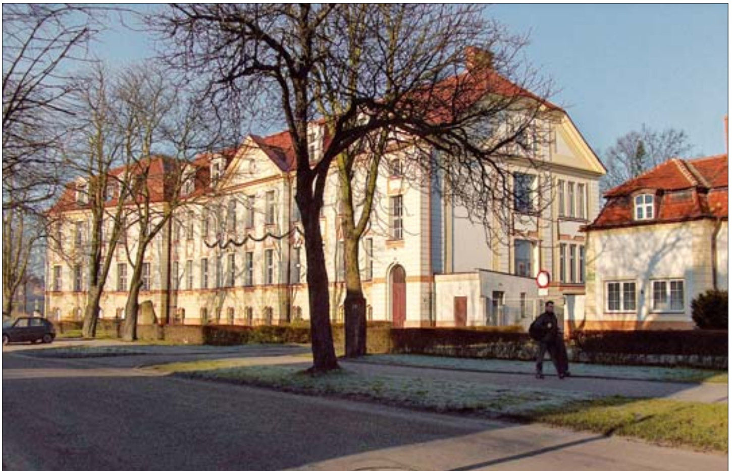
1. Gmach Urzędu Miasta w Białogardzie, widok od strony południowej, ul. 1 Maja 18. 1. Building of the Municipal Office in Białogard, view from the south, 18 1 Maja Street.
