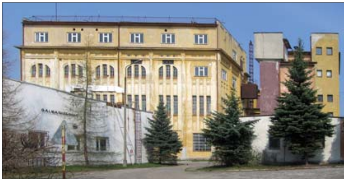
23. Budynek dawnej elektrowni w zespole UNICON, ul. Świdwińska 22-24.
