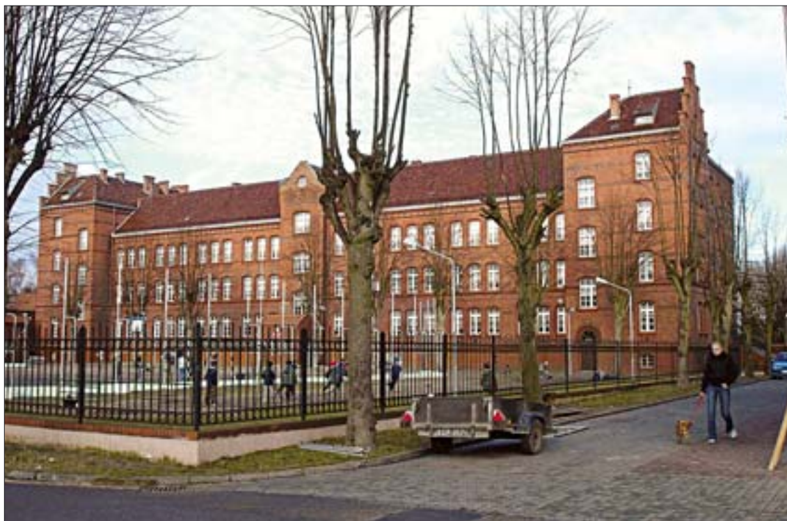
8. Gmach koszar, ul. Kołobrzeska 21-23. 8. Military barracks in 21-23 Kołobrzeska Street.
