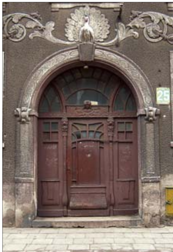
19. Dekoracja obramienia bramy domu przy ul. Klonowej 25. 19. Decoration of a gate frame in a house in 25 Klonowa Street.
