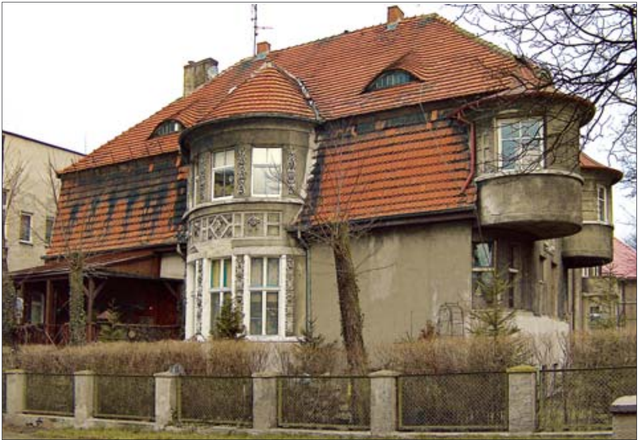
11. Willa, ul. Sikorskiego 36. 11. Villa, 36 Sikorskiego Street.
