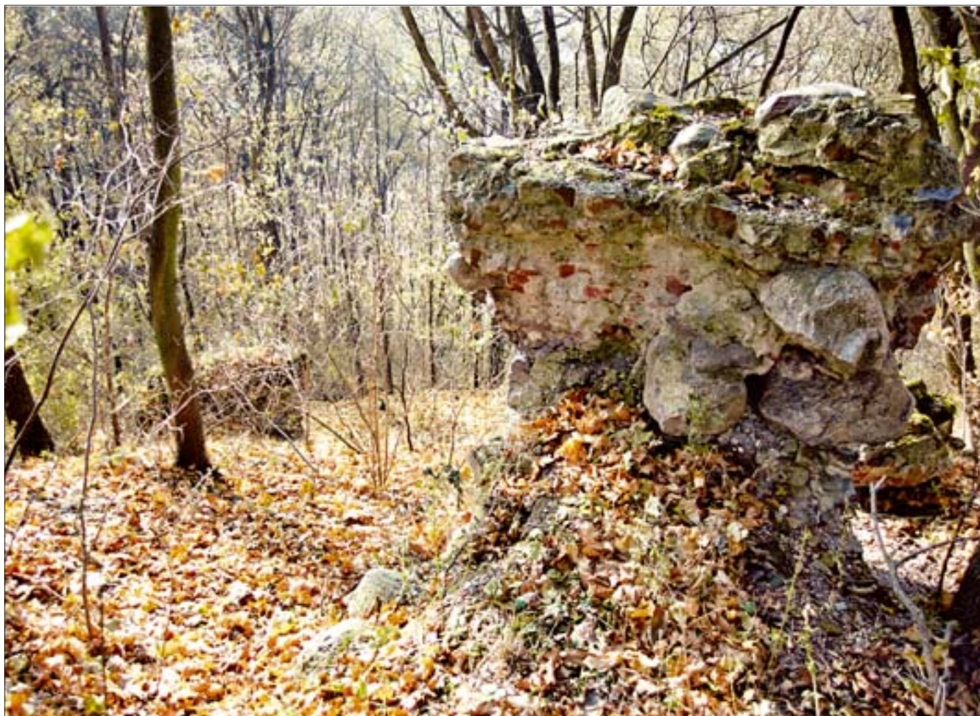
20. Zamek wysoki, fragment muru skrzydła zachodniego, widok w kierunku zachodnim. Fot. autorka, 2004 r. 20. High castle, fragment of the western wing wall, view towards the west. Photo: author, 2004.
