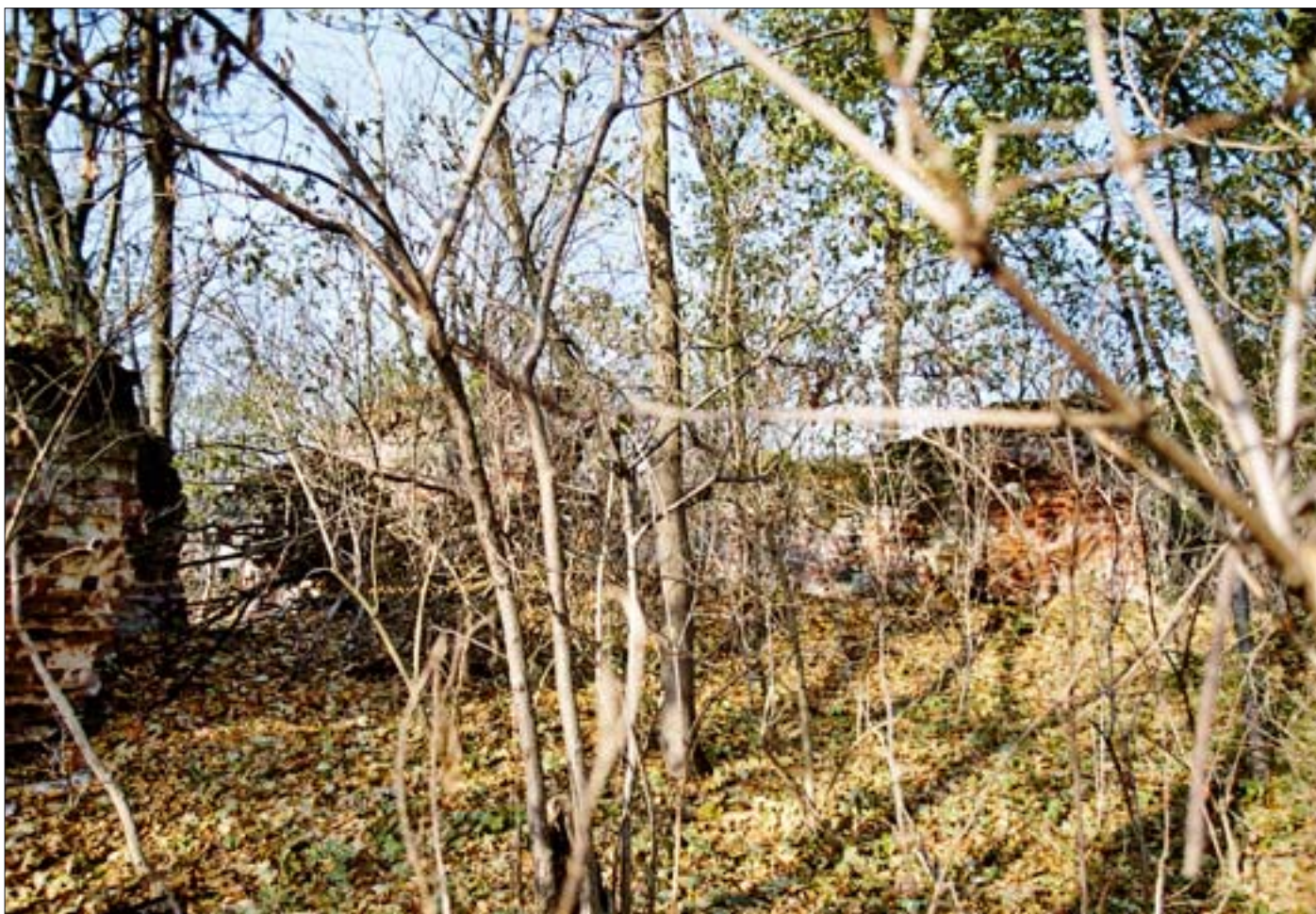
21. Zamek wysoki, fragment muru skrzydła północnego, widok w kierunku północnym. Fot. autorka, 2004 r. 21. High castle, fragment of the northern wing wall, view towards the north. Photo: author, 2004
