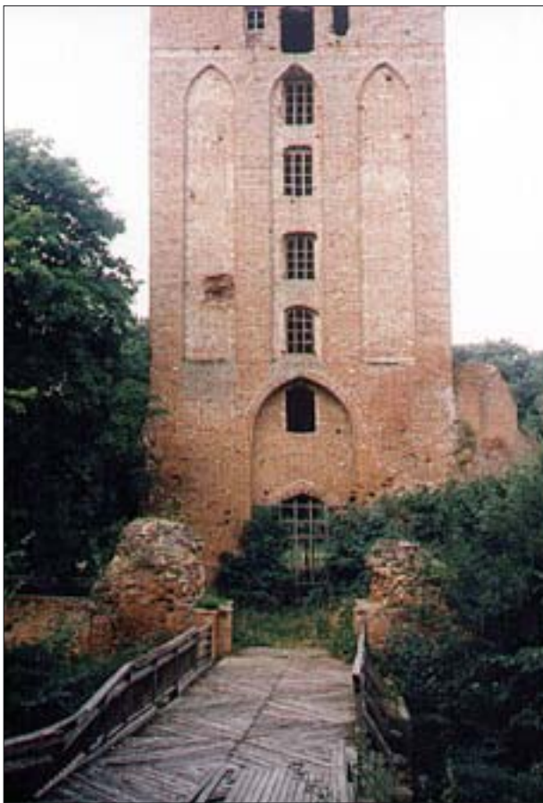
2. Nieistniejący dziś most. Fot. Z. Jabłoński, 1999 r. 2. Bridge during the 1990s, today: nonexant. Photo: Z Jabłoński, 1999.
