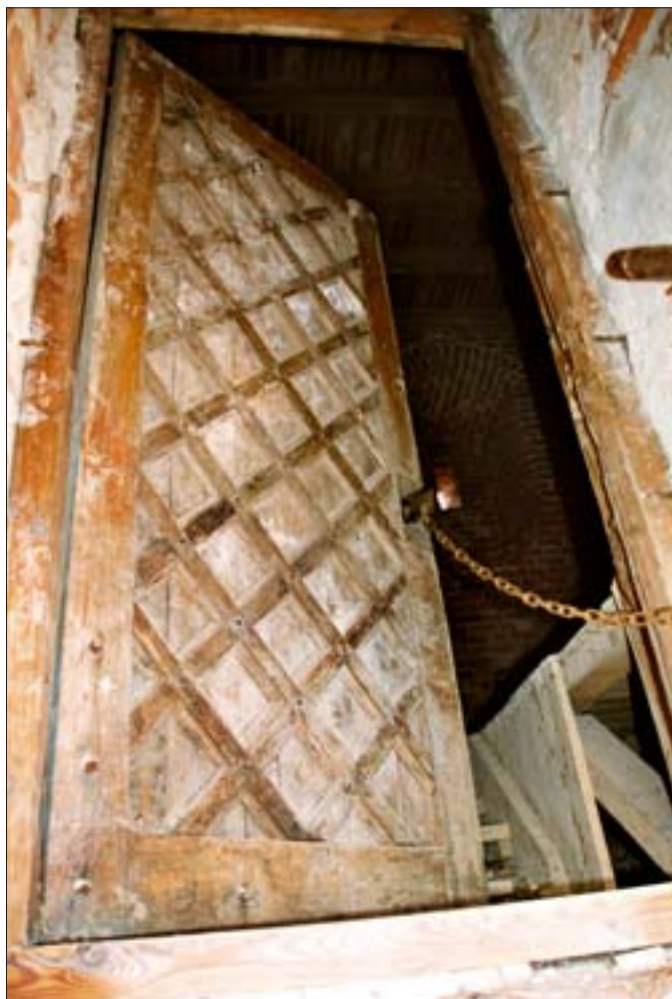
12. Wieża, elewacja pd.-wsch., pierwsze piętro, drzwi wejściowe. Fot. autorka, 2004 r.
