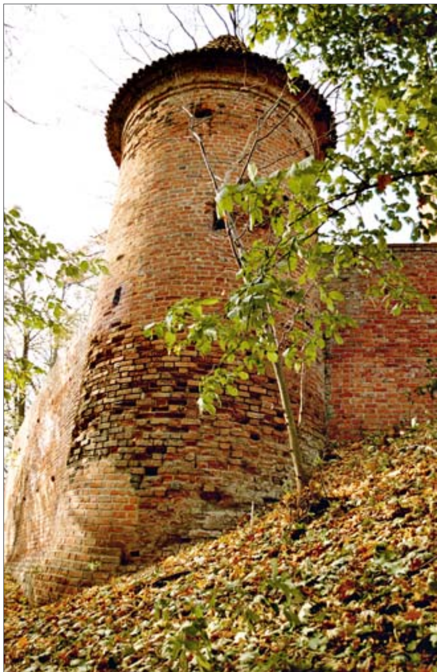
16. Narożna wieżyczka (pd.-wsch.) w ciągu muru obronnego wewnętrznego przedzamcza, widok w kierunku pn.-zach. Fot. autorka, 2004 r.
