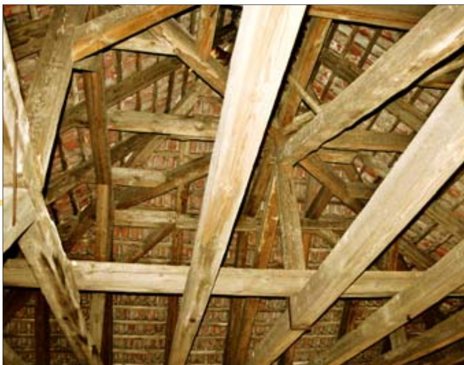
13. Wieża, wnętrze czwartego piętra, więźba dachowa. Fot. autorka, 2004 r. 13. Tower, interior of fourth storey, roof truss. Photo: author, 2004.
