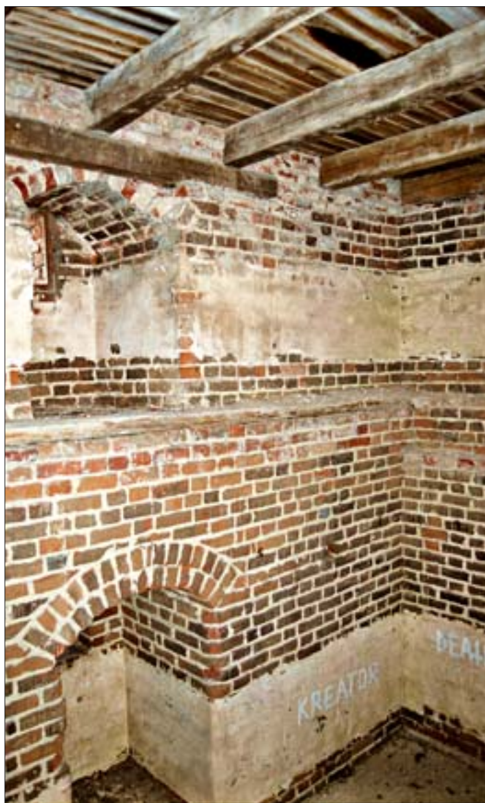
14. Wieża, wnętrze drugiego piętra, odsadzka w murze, widok w kierunku wschodnim. Fot. autorka, 2004 r. 14. Tower. Interior of second storey, offset in the wall, view towards the east. Photo: author, 2004.
