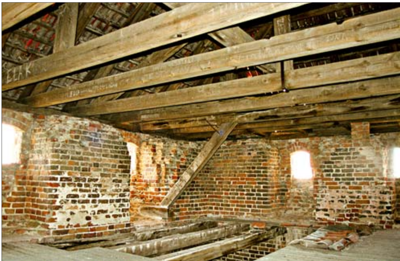
15. Wieża, wnętrze czwartego piętra, więźba dachowa. Fot. autorka, 2004 r. 15. Tower, interior on fourth storey, roof truss. Photo: author, 2004.
