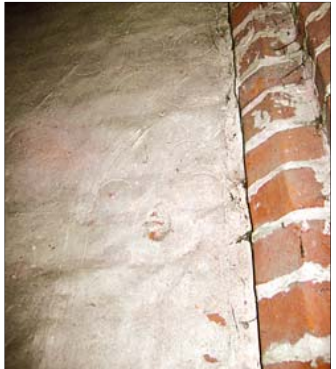
9. Blenda nr 1, widok fragmentu skrajnej osi prawej dekoracji maswerkowej. Płatki czwórliści o wykroju lancetowym, płatki pięćliści w lancetach o wykroju kolistym. 9. Blind window no. 1, view of a fragment of the extreme right axis of the tracery decoration. The petals of the four-leaf motif have a lancet pattern, the petals of the five-leaf motif are in circular lancets.
