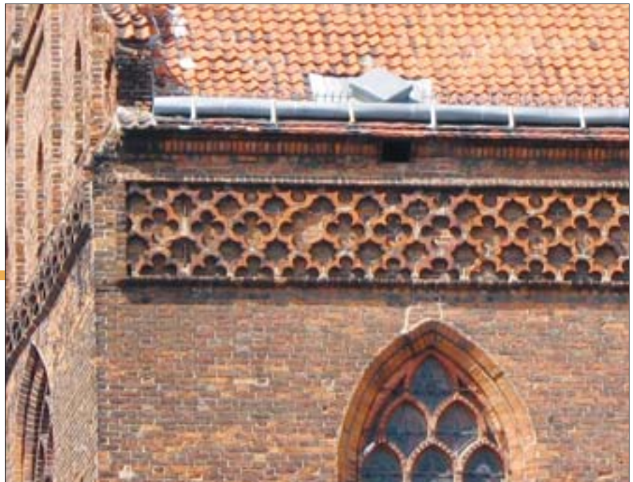
21. Toruń, kościół p.w. Najświętszej Marii Panny, ceglana dekoracja fryzu koronującego elewację korpusu wykonana z kształtek ceglanych. 21. Toruń, church of the Holy Virgin Mary, brick decoration of the frieze crowning the corps elevations in the form of brick-shaped stone.
