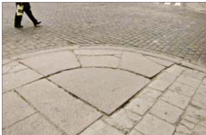
18. Szczecin, al. Jedności Narodowej/Wielkopolska, narożnik chodnika z nawierzchnią wykonaną z płyt granitowych, stan z 2004 r. 18. Szczecin, Jedności Narodowej/Wielkopolska Avenue, pavement quin with surface made of granite slabs, state in 2004.
