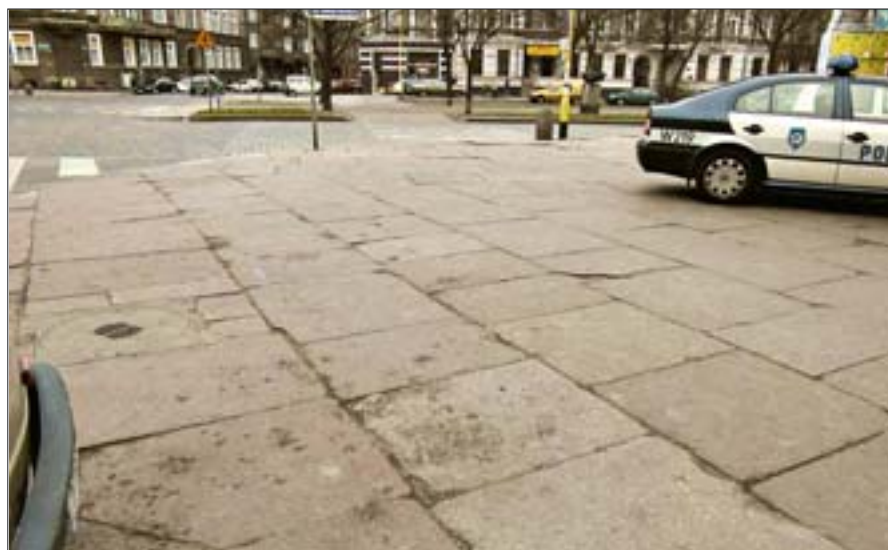
19. Szczecin, al. Jedności Narodowej/Mazurska, chodnik z nawierzchnią wykonaną z płyt granitowych, stan z 2004 r. 19. Szczecin, Jedności Narodowej/Mazurska Avenue, pavement with surface made of granite slabs, state in 2004.
