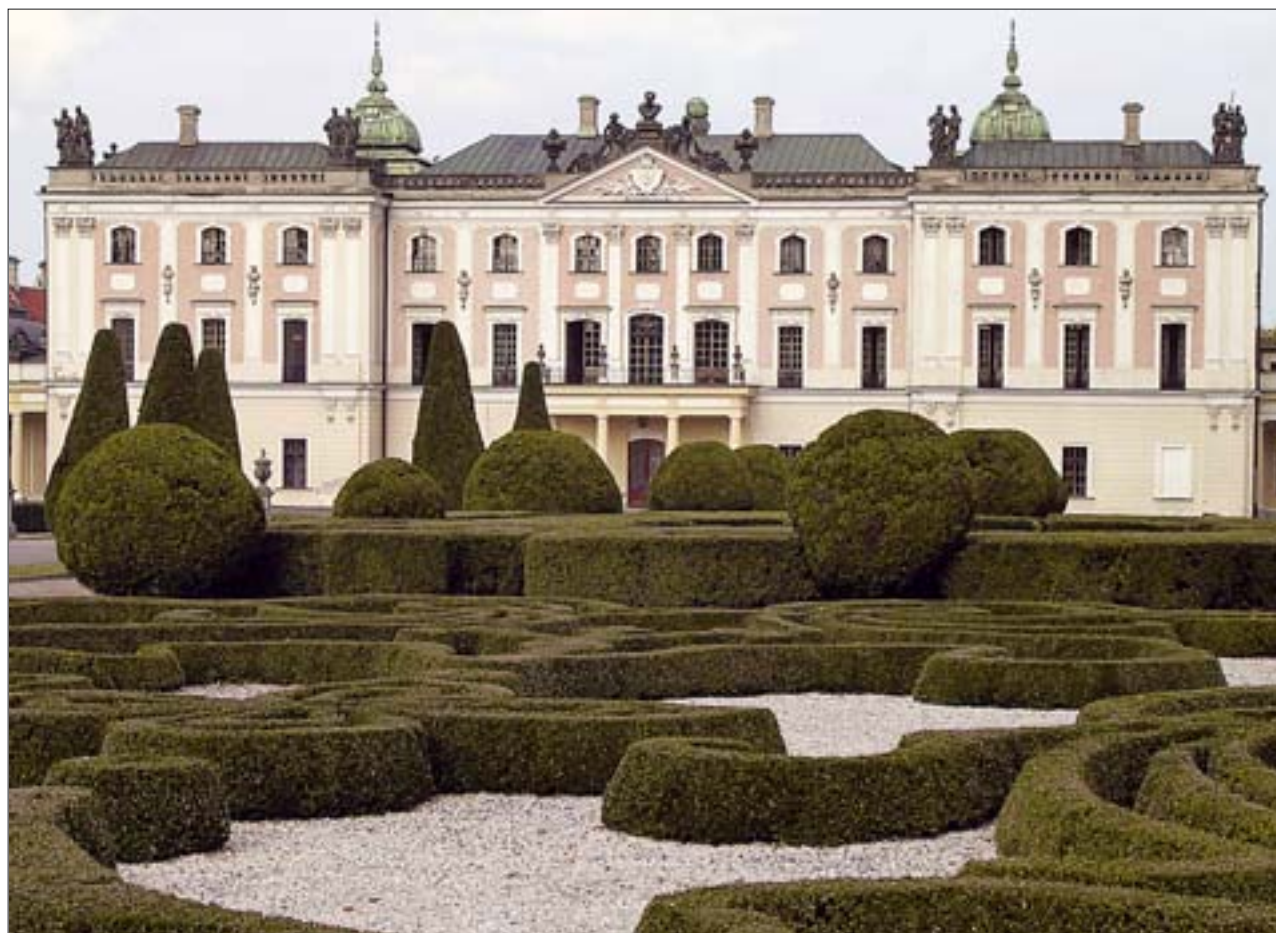
10. Zrekonstruowany parter haftowy. Fot. D. Sikora, 2005 r. 10. Reconstructed parterre en broderie. Photo: D. Sikora, 2005.
