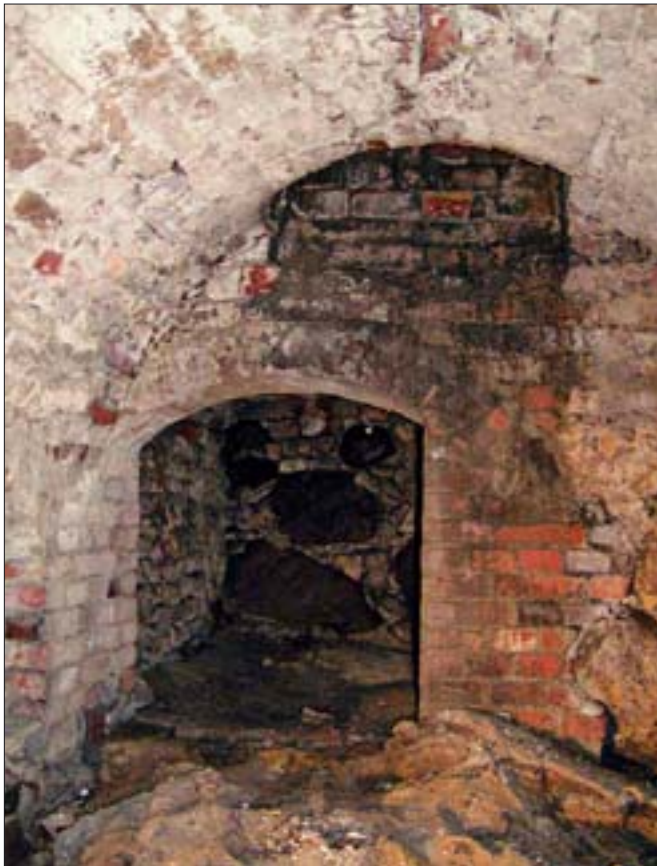
14. Odkryta piwnica kamienicy przy południowo-zachodnim narożniku ratusza.
