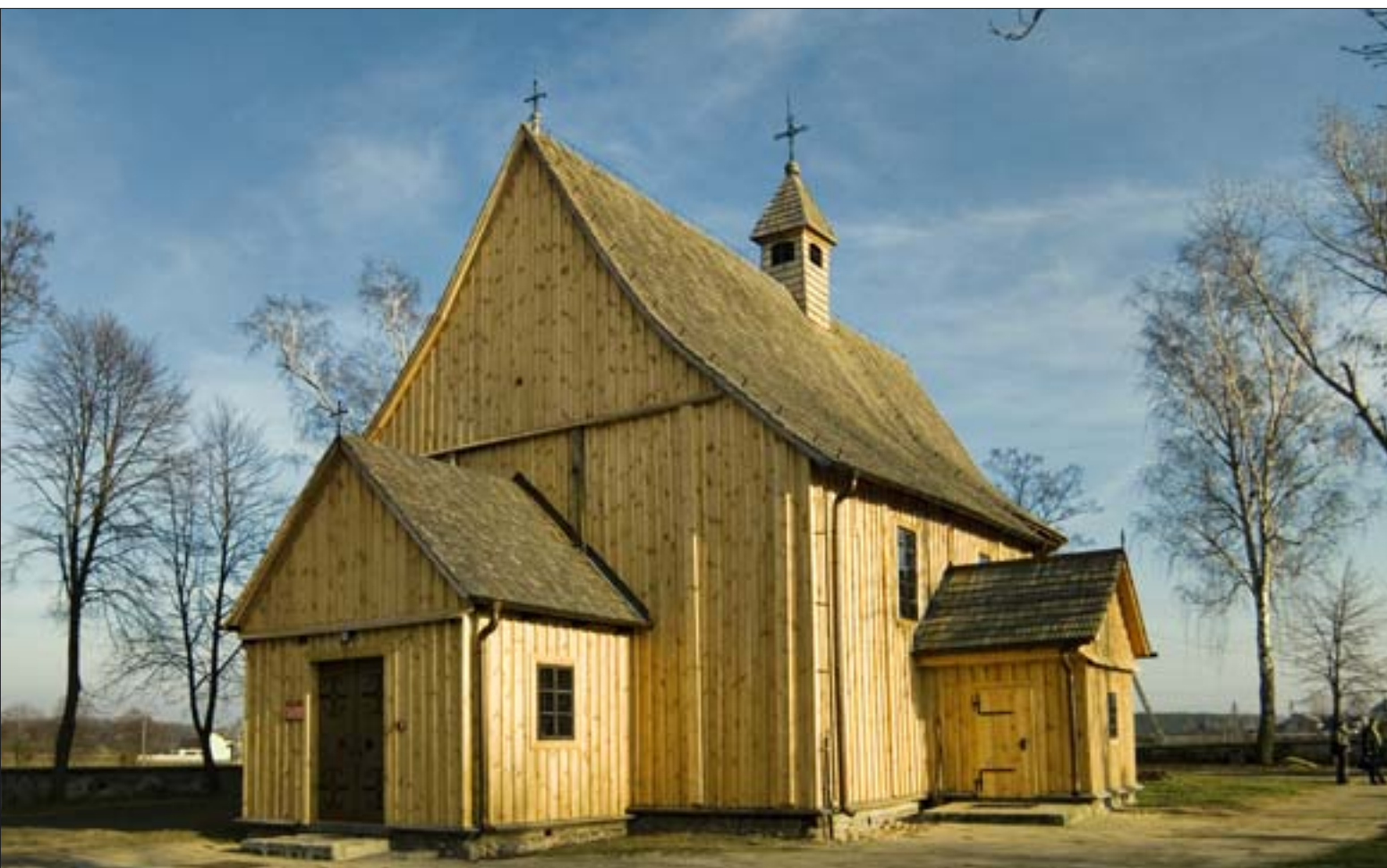
1. Kościół pw. św. Stanisława biskupa w Boguszycach, widok od strony południowo-zachodniej. Stan po konserwacji. Fot. R. Stasiuk. 1. Church of St. Stanisław the Bishop in Boguszyce, view from the south-west. State after conservation. Photo: R. Stasiuk.
