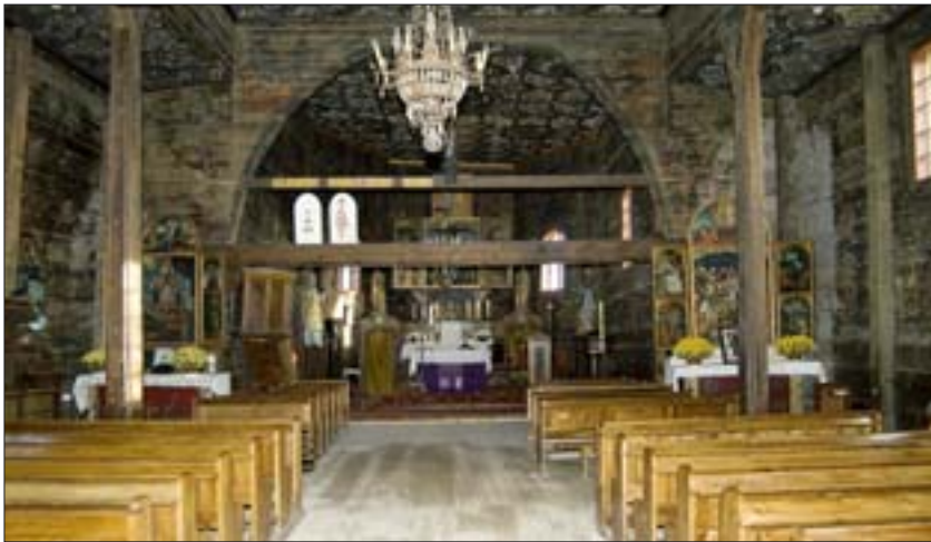
3. Wnętrze kościoła, widok na prezbiterium. Poniżej desek osłaniających ściąg metalowy widoczna belka tęczowa umieszczona w pierwotnym miejscu w 1999 r. Fot. R. Stasiuk. 3. Church interior, view of the presbytery. Below the boards protecting the metal roof beam – a visible rood beam installed in its original place in 1999. Photo: R. Stasiuk.
