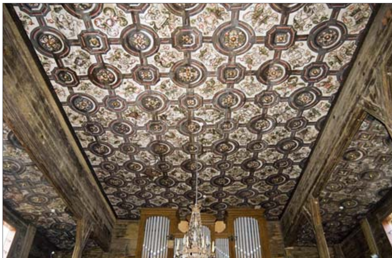
7. Strop nawy głównej, widok w kierunku chóru muzycznego. Stan po konserwacji. Fot. R. Stasiuk. 7. Ceiling of the main nave, view towards the choir. State after conservation. Photo: R. Stasiuk.
