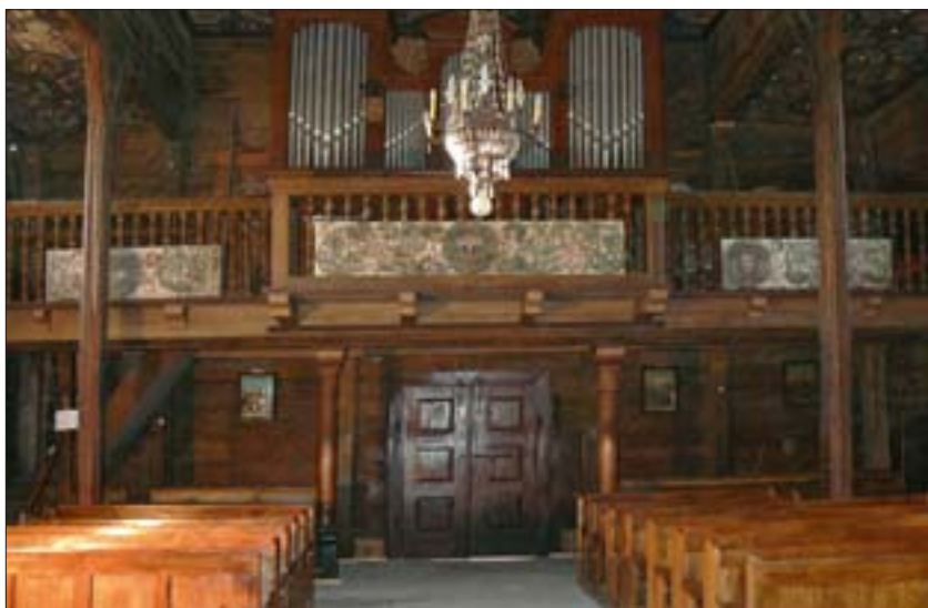
3. Wnętrze kościoła, widok na prezbiterium. Poniżej desek osłaniających ściąg metalowy widoczna belka tęczowa umieszczona w pierwotnym miejscu w 1999 r. Fot. R. Stasiuk. 3. Church interior, view of the presbytery. Below the boards protecting the metal roof beam – a visible rood beam installed in its original place in 1999. Photo: R. Stasiuk.
