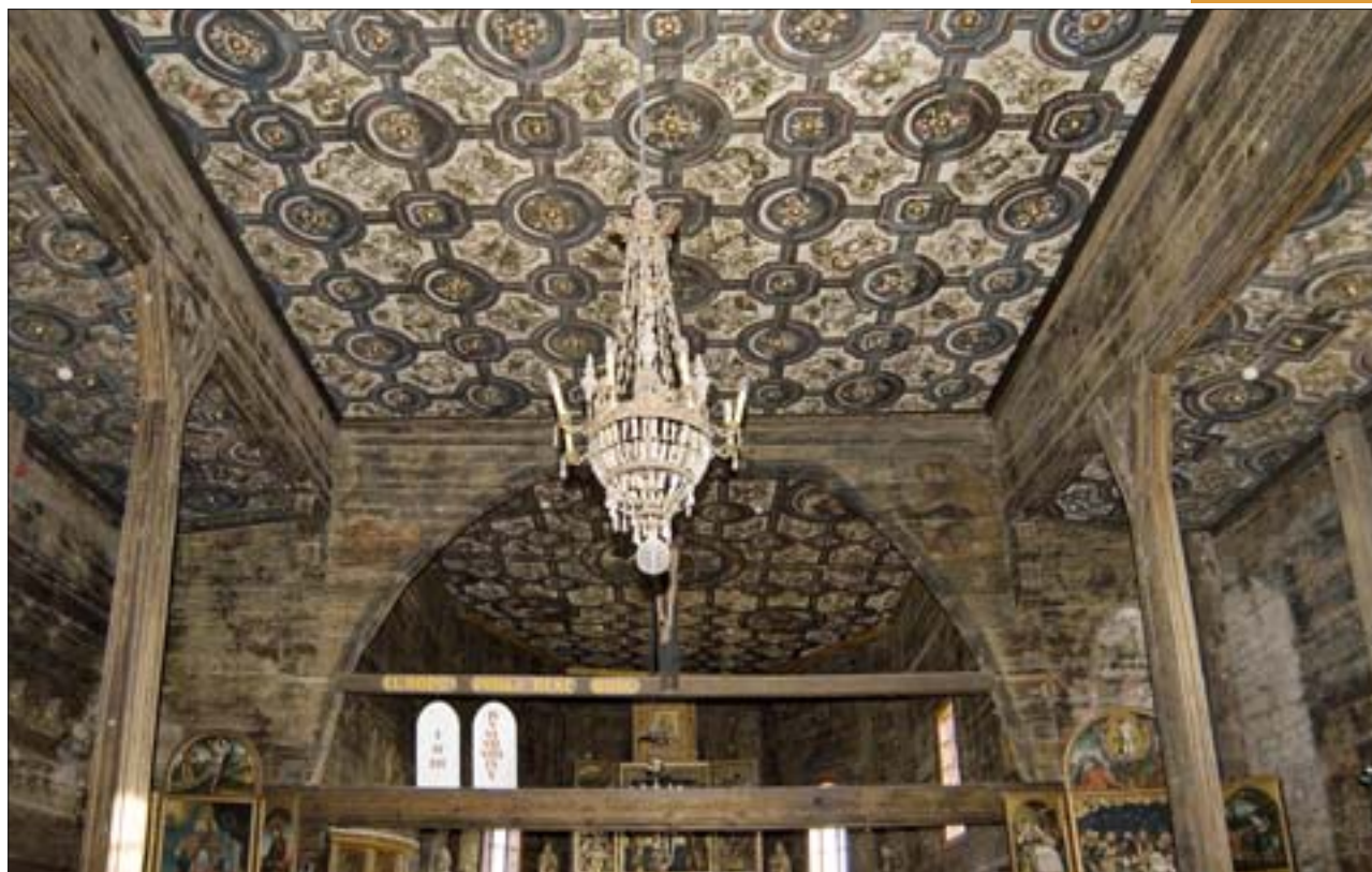
6. Strop nawy głównej, widok w kierunku prezbiterium. Stan po konserwacji. Fot. R. Stasiuk. 6. Ceiling of the main nave, view towards the presbytery. State after conservation. Photo: R. Stasiuk.
