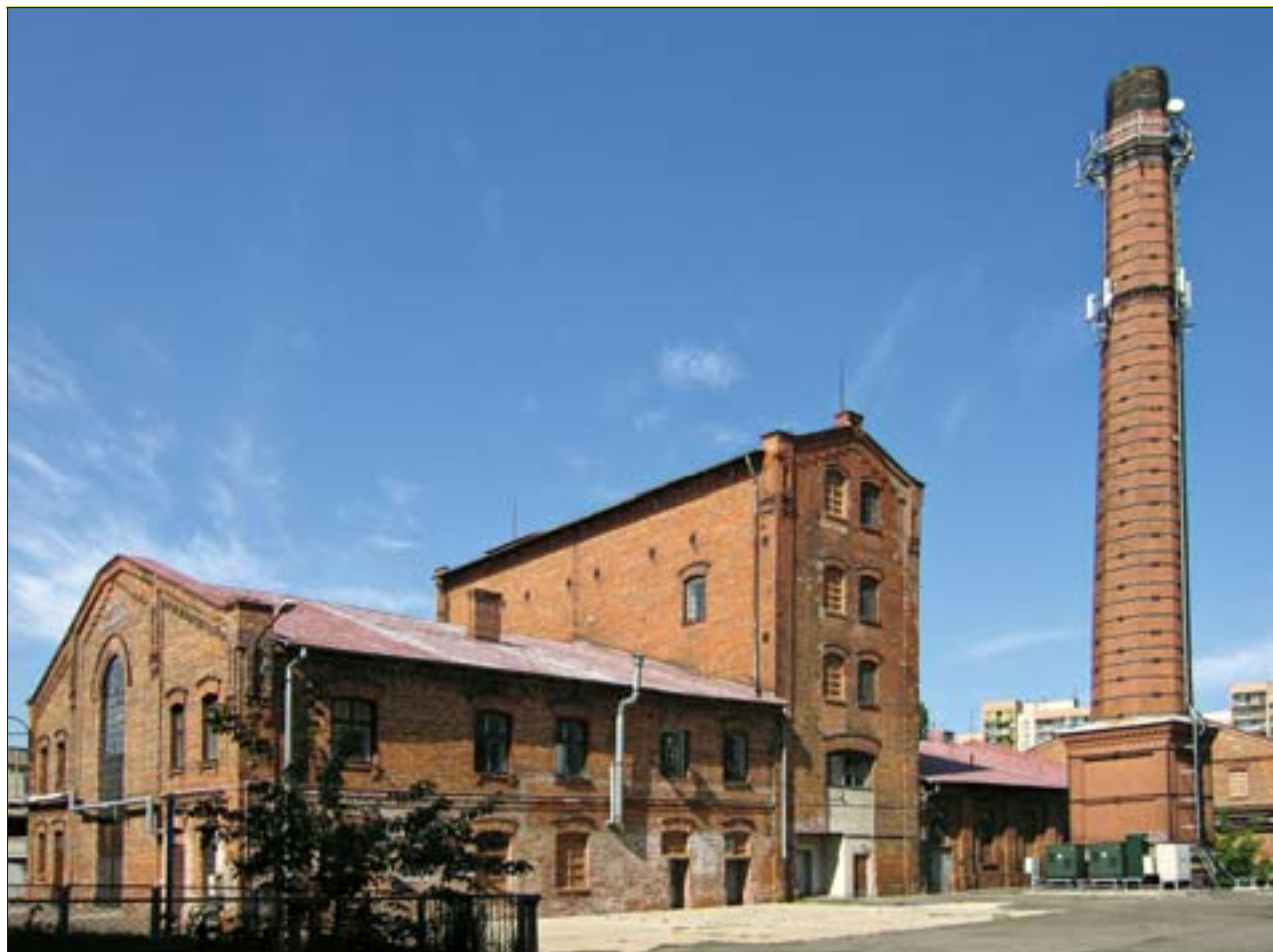
6. Warszawa, wytwórnia wódek „Koneser”. Teren zakładu. 6. Warsaw, "Koneser" Vodka Factory. Area of the works.
