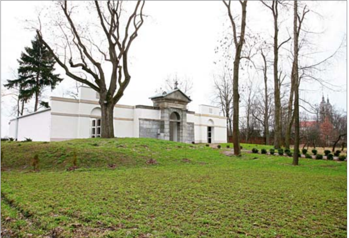
10. Widok ogólny fasady rozbudowanego założenia. Na osi założenia bryła wzniesiona w 1910 r. 10. General view of the facade of the expanded premise. On the axis of the premise – a solid erected in 1910.
