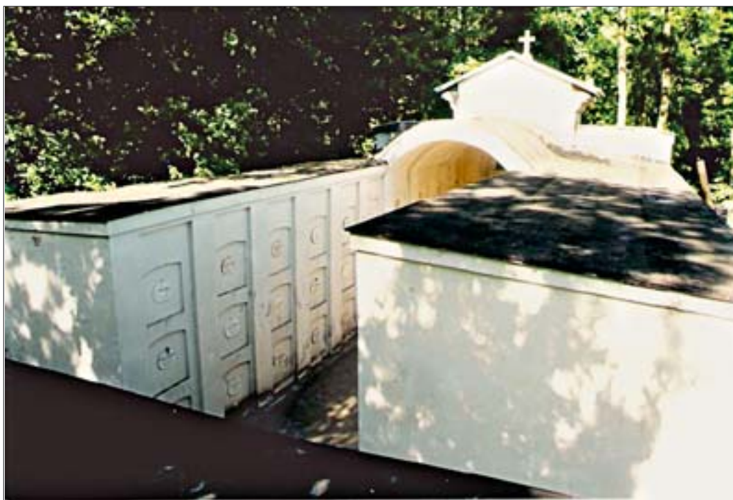
4. Widok katakumb od strony północno-wschodniej. Stan z 2000 r. (przed rozbudową). Dwa równoległe pasy zabudowy zamknięte są od strony wejścia monumentalnym portalem; u dołu trzeci, poprzeczny pas zabudowy. 4. View of the catacombs from the northeast. State in 2000 (prior to the expansion). Two parallel strips are closed from the entrance by means of a monumental portal; at the bottom – a third, diagonal strip.
