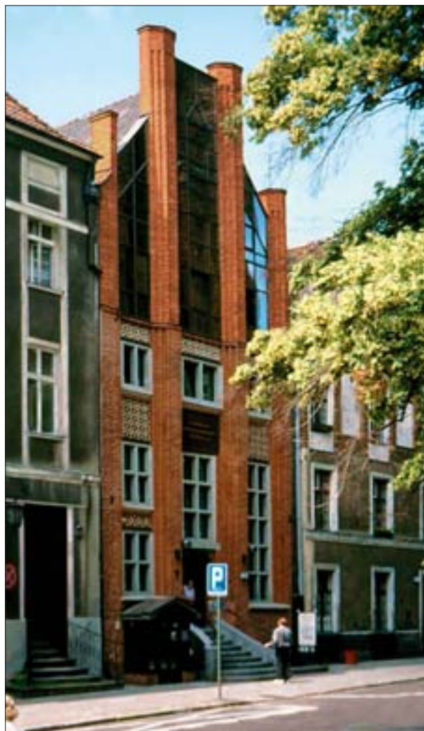
5. Toruń, ul. Żeglarska 13. Dobry przykład współczesnej interpretacji niezachowanego szczytu, dzięki wyważonej proporcji szkła w stosunku do ceglanych lizen. Nie ma tu przysłowiowej „dziury”. Zastrzeżenie może budzić jedynie ceglana rolka zastosowana w lizenach sugerująca, że tu mogły się one kończyć. Fot. J. Tajchman.
