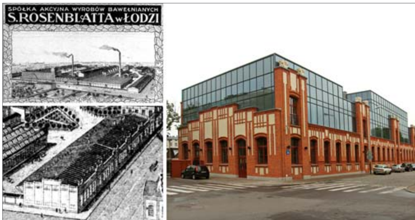
9. Łódź, ul. Żwirki 36. Jeden z budynków dawnej fabryki Szei Rosenblatta, który pokazuje winieta reklamowa (z lewej), został całkowicie rozebrany i postawiony z nowej cegły z jednoczesną zmianą wielu istotnych elementów i szklaną nadbudową dwóch kondygnacji (po prawej). Ta, trzeba przyznać, interesująca forma nie ma nic wspólnego z ochroną historycznej zabudowy ani nawet z tzw. rewitalizacją, jak próbuje się nazwać to dzieło zakłamania. Fot. J. Tajchman.
