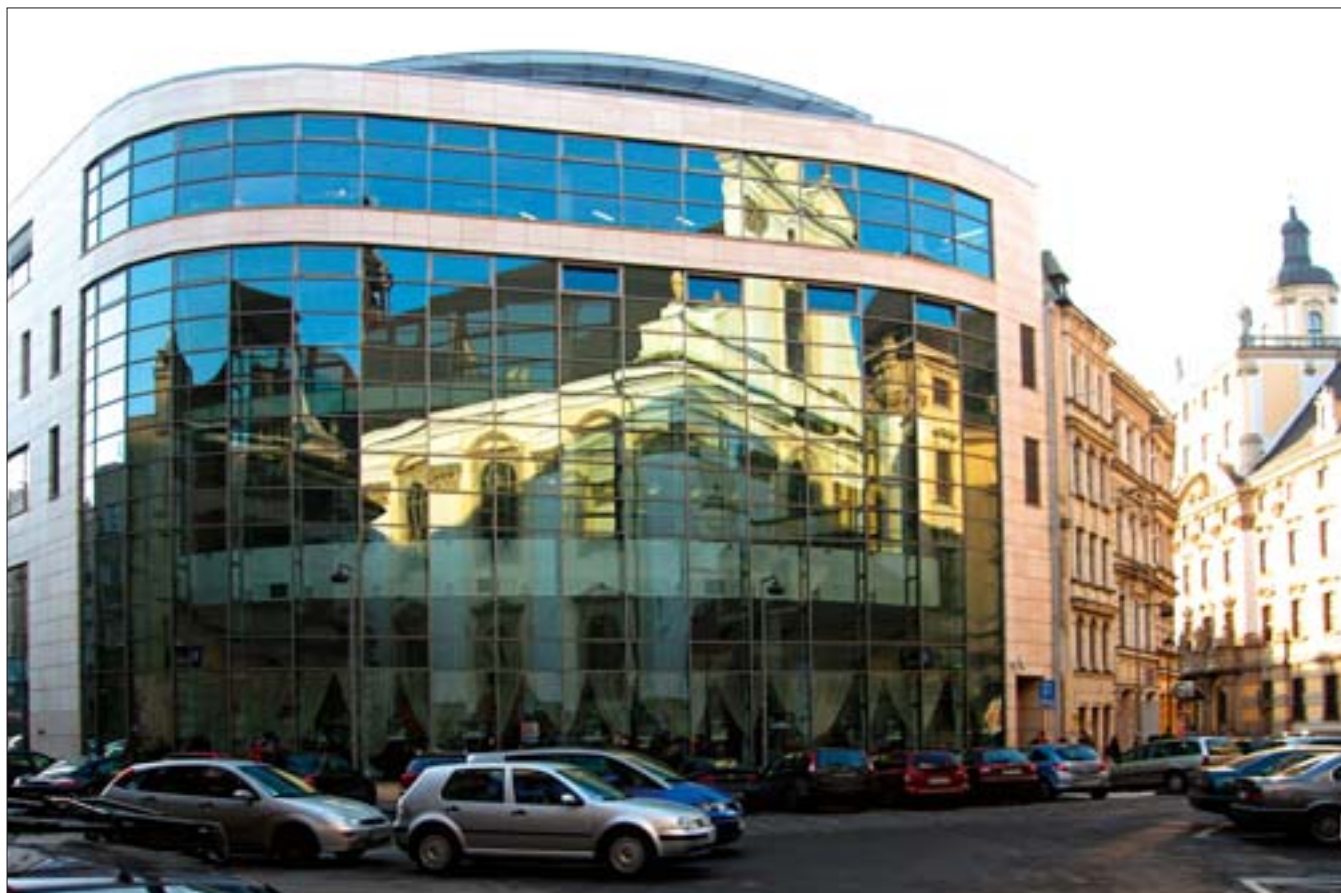
6. Wrocław, plac Uniwersytecki. Jeden z niewielu przykładów, w którym szkło nie tworzy „dziury” w pierzei, gdyż zostało zastosowane w ściętym narożniku. W szkłe tym odbija się zabytkowa zabudowa, efekt ten ogranicza poziomy górny pas tynku. Fot. J. Tajchman.
