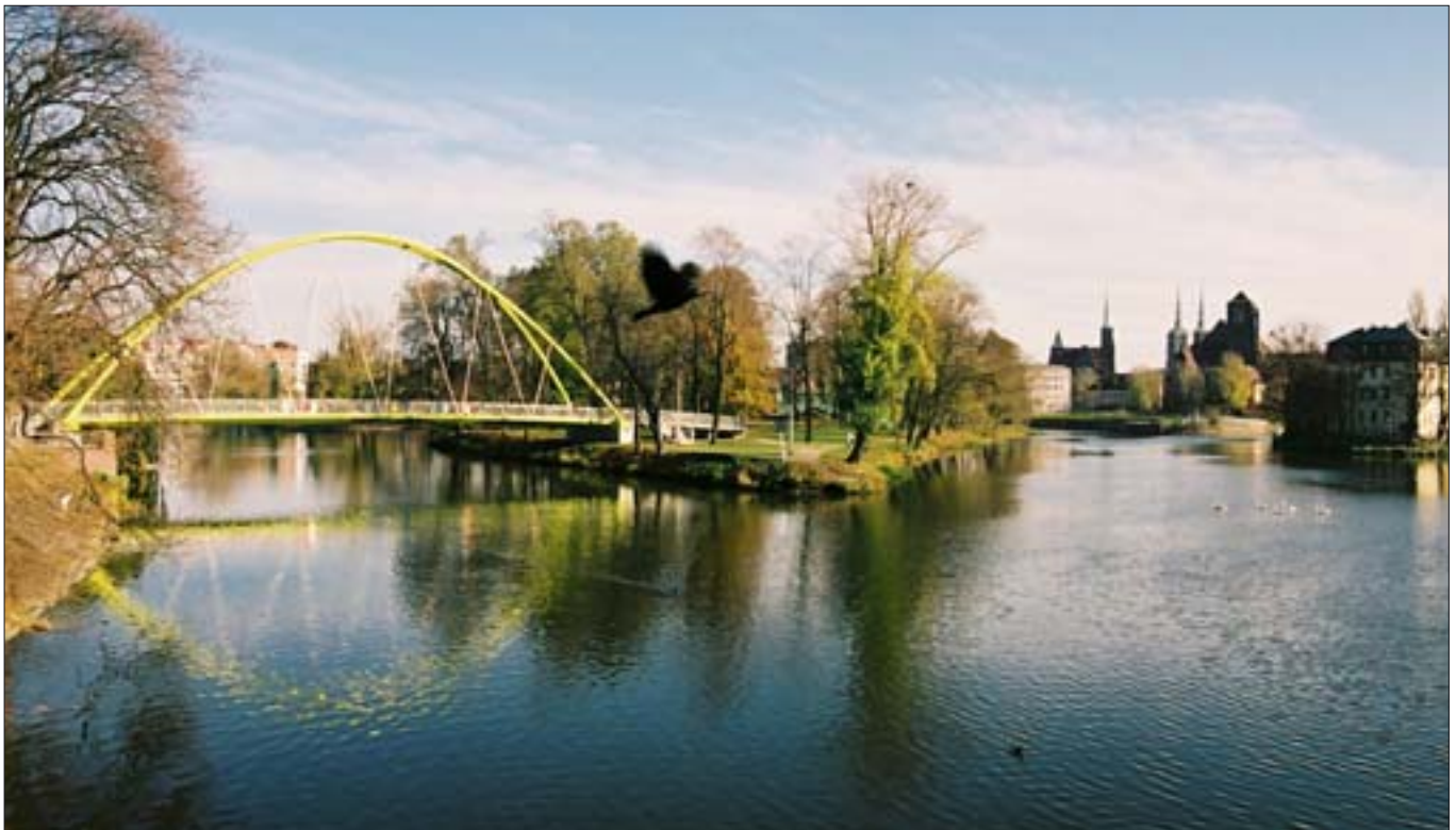
14. Widok kładki Słodowej i Ostrowa Tumskiego. Proj. J. Styrylska, T. Boniecki. Fot. R. Eysymontt.
