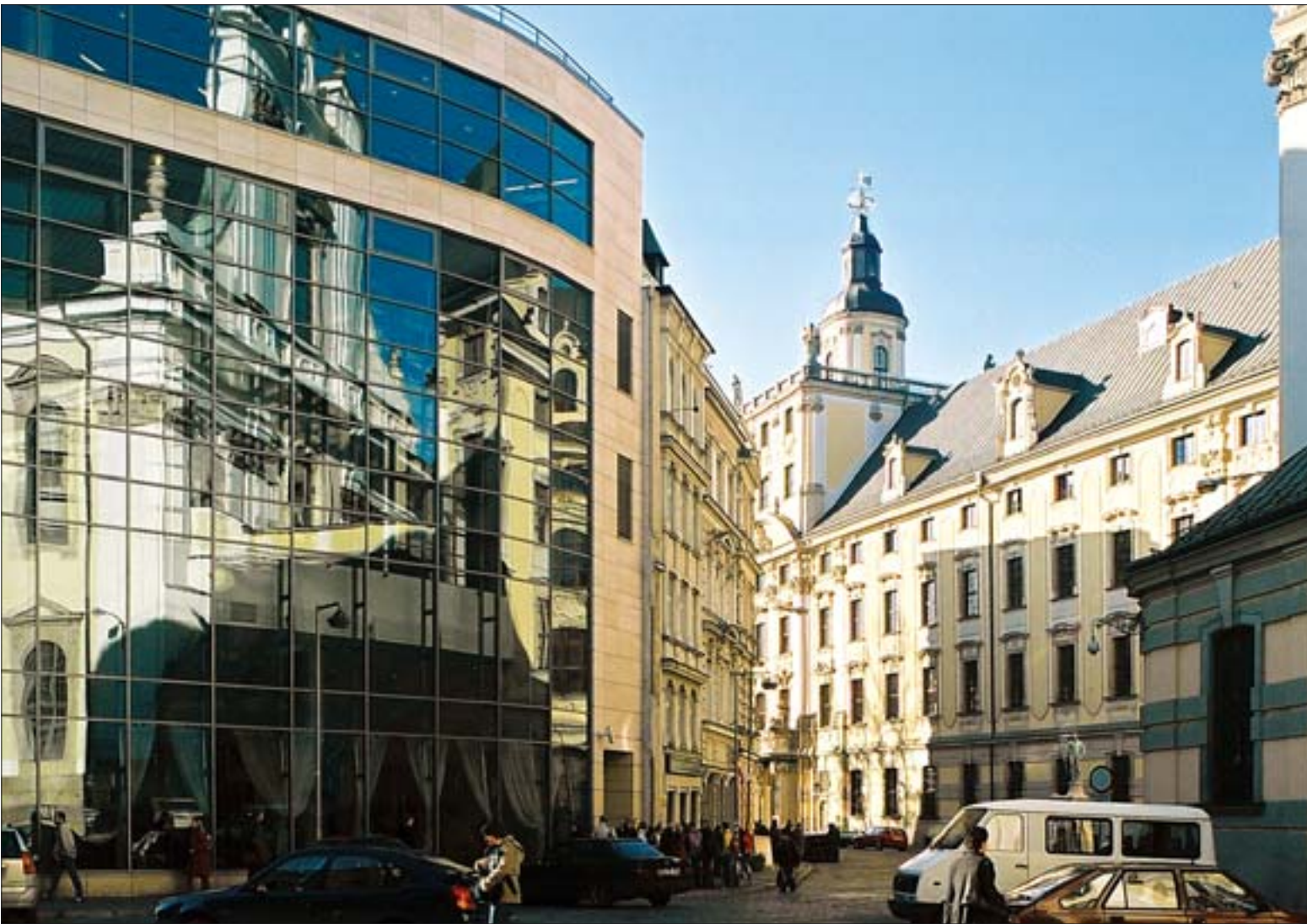
1. Nowy gmach Wydziału Prawa Uniwersytetu Wrocławskiego. Proj. Pracownia Projektowa Zbigniew Maćków. Fot. R. Eysymontt.
