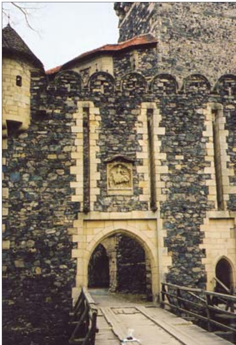
7. Portal bramy wjazdowej z umieszczoną nad wjazdem płaskorzeźbą św. Jerzego. Fot. M. Labus.
