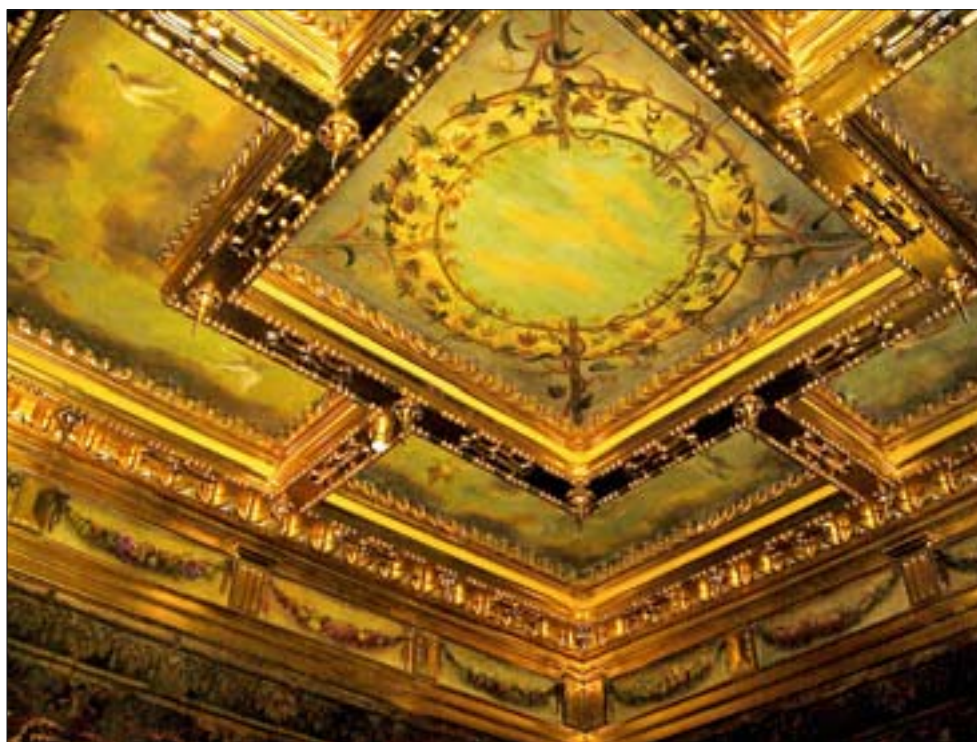
10. Ramiasty strop sieni Kurzej Stopki wykonany wg projektu Adolfa Szyszko-Bohusza, z malowidłami z lat 30. XX w., stan obecny. Fot. P. Stępień.
