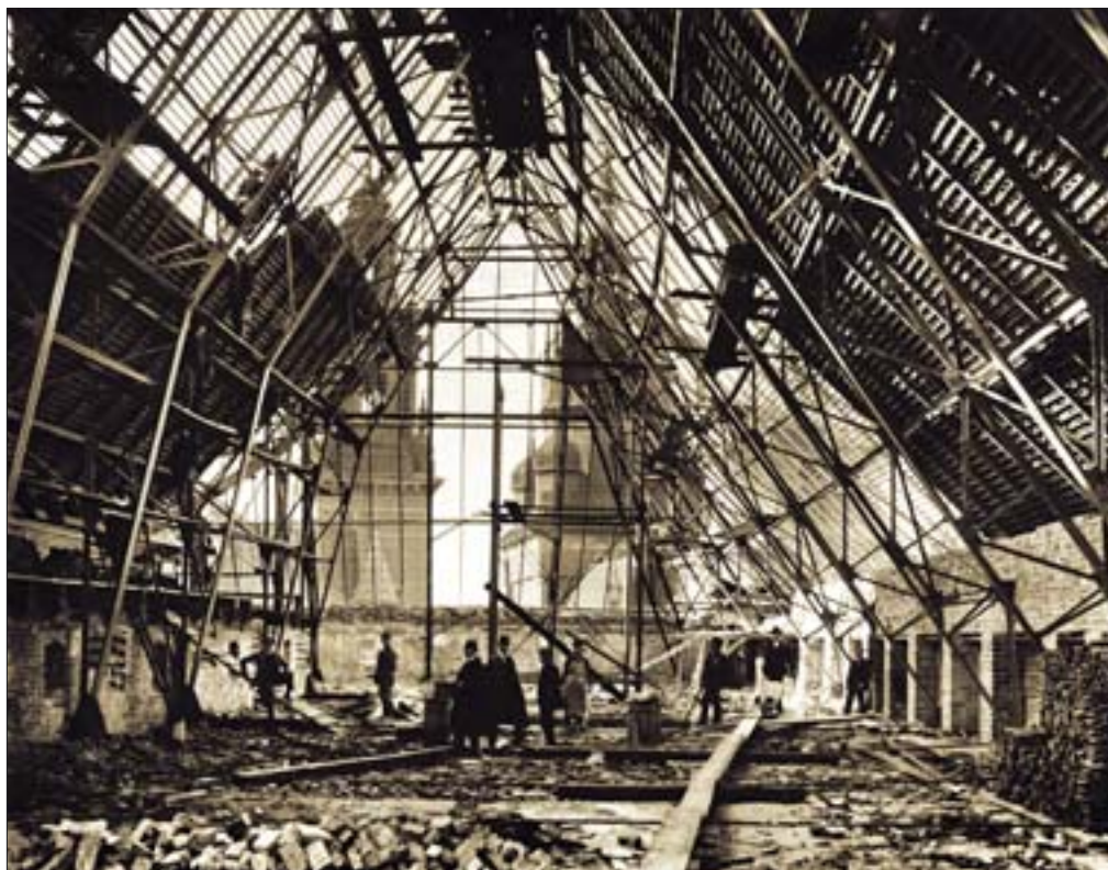
7. Montaż konstrukcji dachu nad skrzydłem północnym wg projektu Zygmunta Hendla. Zbiory Zamku Królewskiego na Wawelu. 7. Assembly of the roof construction above the northern wing acc. to a project by Zygmunt Hendel. Collections of Royal Castle on Wawel Hill.
