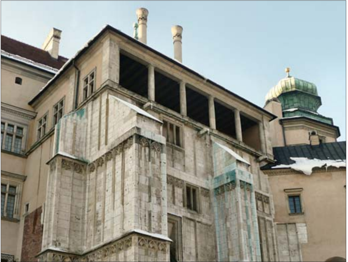
15. Loggia na wieży Duńskiej wg projektu Adolfa Szyszko-Bohusza, stan obecny. Fot. P. Stępień. 15. Loggia on Duńska Tower acc. to a project by Adolf Szyszko-Bohusz, present-day state. Photo: P. Stępień.
