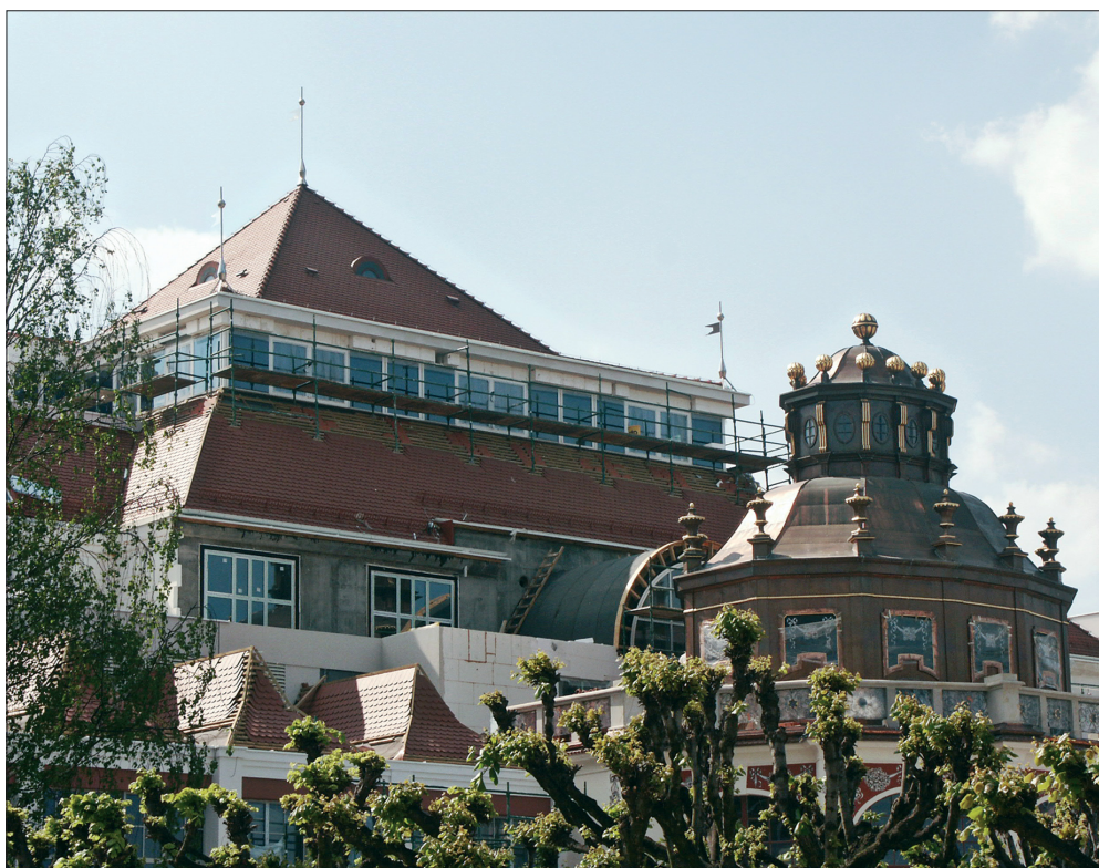
16. Sopot, zespół mola i relikty Domu Zdrojowego III, wpisane do rejestru zabytków w 1982 r. Trwają prace przy rekonstrukcji kopuły – do niedawna jedynej pozostałości dawnej oryginalnej zabudowy kuracyjnej. Ostatnio całkowicie zniszczona podczas budowy nowego domu zdrojowego. Termin zakończenia prac – rok 2009 – stanie się metryką nowego zabytku nadal wpisane do rejestru. Fot. M. Gawlicki. 16. Sopot, the pier and relics of Kurhaus III, in the register of historical monuments since 1982. Work is being conducted on the reconstruction of the dome – until recently the only remnant of the original building. Recently completely damaged during the construction of a new Kurhaus. The deadline – 2009 – will become the birth certificate of a new monument still in the register. Photo: M. Gawlicki.
