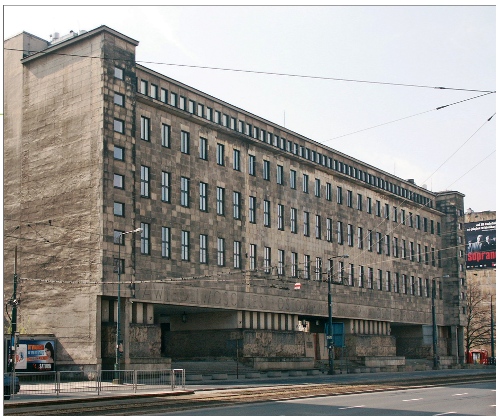
13. Warszawa, gmach Sądów Grodzkich, wzniesiony wg projektu Bohdana Pniewskiego w latach 1935-1939, niewpisany do rejestru zabytków. Fot. M. Gawlicki. 13. Warszawa, building of the Borough Courts, erected according to a design by Bohdan Pniewski in 1935-1939, not in the register of historical monuments. Photo: M. Gawlicki.
