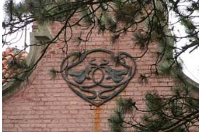
13. Szczyt północny budynku administracyjno-mieszkalnego. Fot. B. Bielinis-Kopeć. 13. Northern gable in the administrative-residential building. Photo: B. Bielinis-Kopeć.
