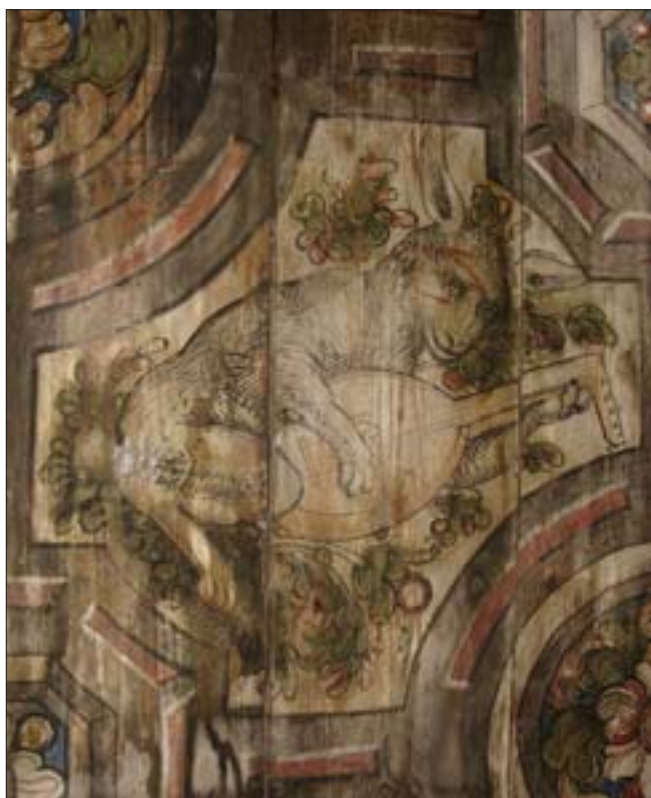
14. Fragment stropu nawy głównej przed konserwacją, przedstawienie zająca grającego na lutni. Fot. autorka.
