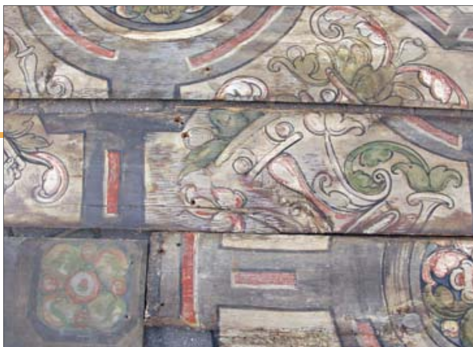
31. Retusze dekoracji malarzkiej stropu nawy głównej pochodzące z konserwacji wykonanej w latach 50. ub.w. Fot. autorka. 31. Retouches of the painted decoration on the main nave ceiling, part of the conservation carried out in the 1950s. Photo: author.
