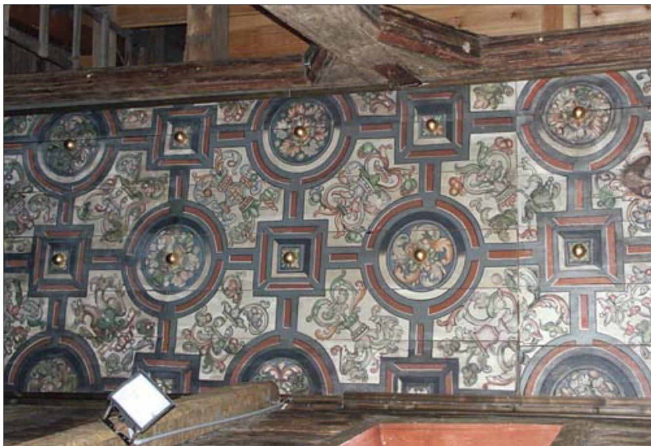
40. Strop nawy północnej po konserwacji. Fot. autorka. 40. Northern nave ceiling after conservation. Photo: author.
