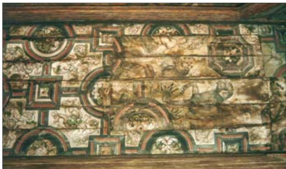
16. Fragmenty stropu nawy północnej przed konserwacją. Widoczne wstawki ze stropu z personifikacjami Grzechów głównych. Fot. R. Stasiuk.
