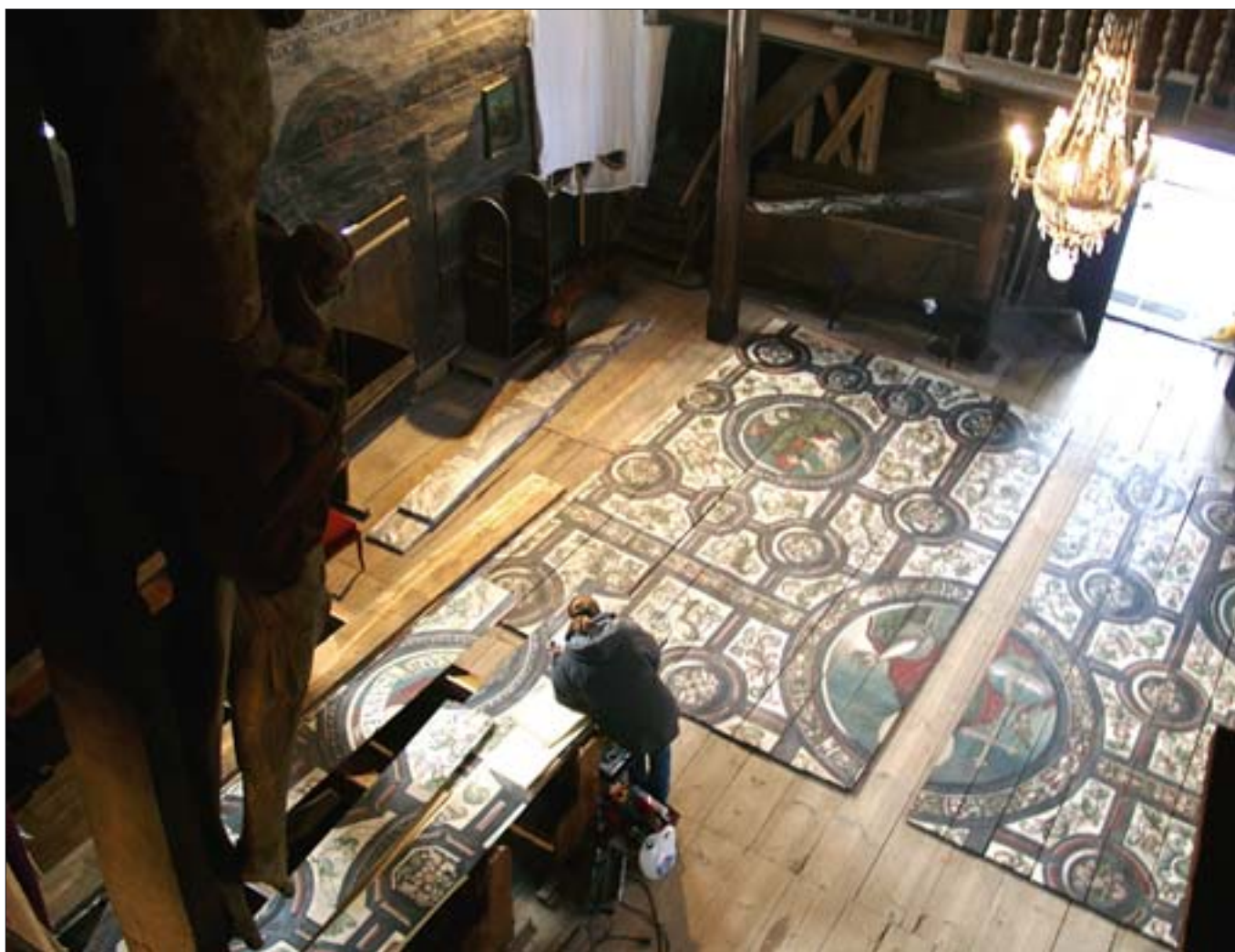
37. Montaż stropu prezbiterium. Fot. autorka.
