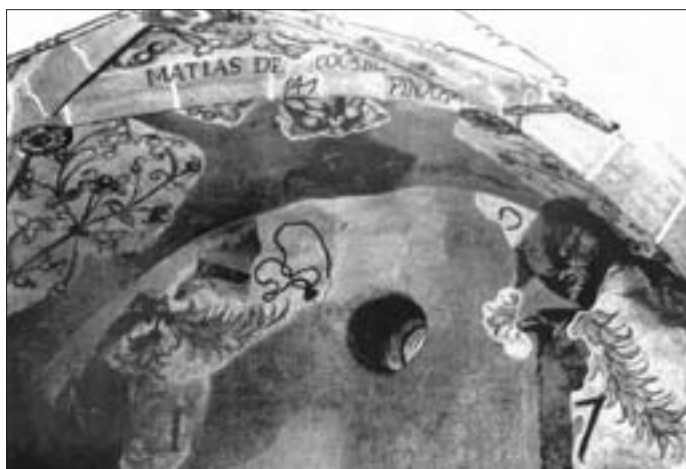
28. Sklepienie kolegiaty w Opatowie z odkrytymi fragmentami malowideł Macieja z Kocka. Fot. Z. Niemojewska.
