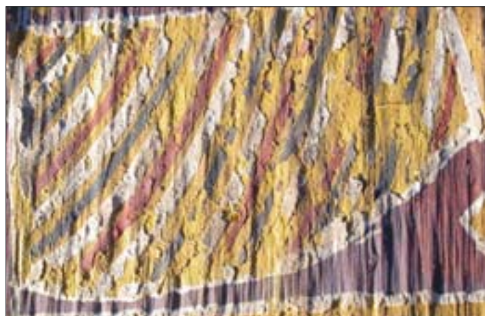
21. Przykłady łuszczącej się warstwy malarskiej. Fot. B. Tworek.
