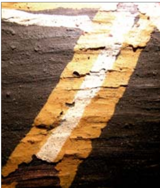
21. Przykłady łuszczącej się warstwy malarskiej. Fot. B. Tworek.
