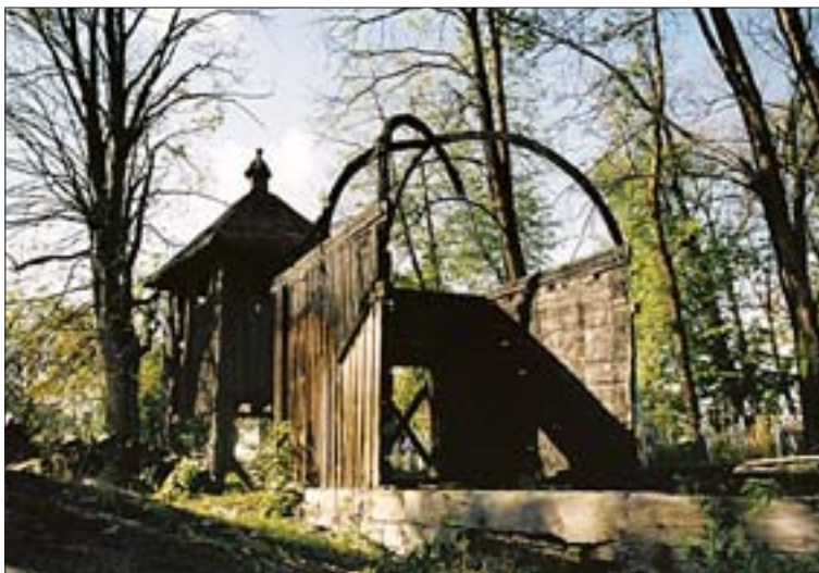
7. Opaka. Cerkiew p.w. Narodzenia NMP, stan po pożarze. Fot. P. Rydzewski.
