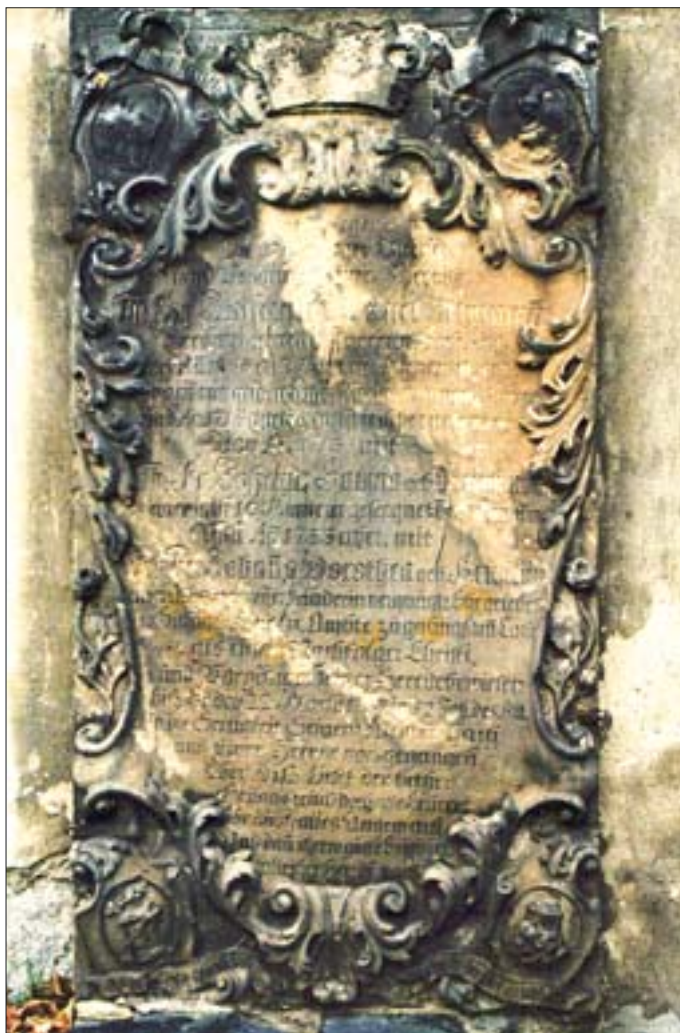
13. Kościelec. Epitafium pastora, widoczny wpływ czynników atmosferycznych na stan zachowania obiektu – zawilgocenie i zwietrzenie materiału. Fot. B. Skoczylas-Stadnik.
