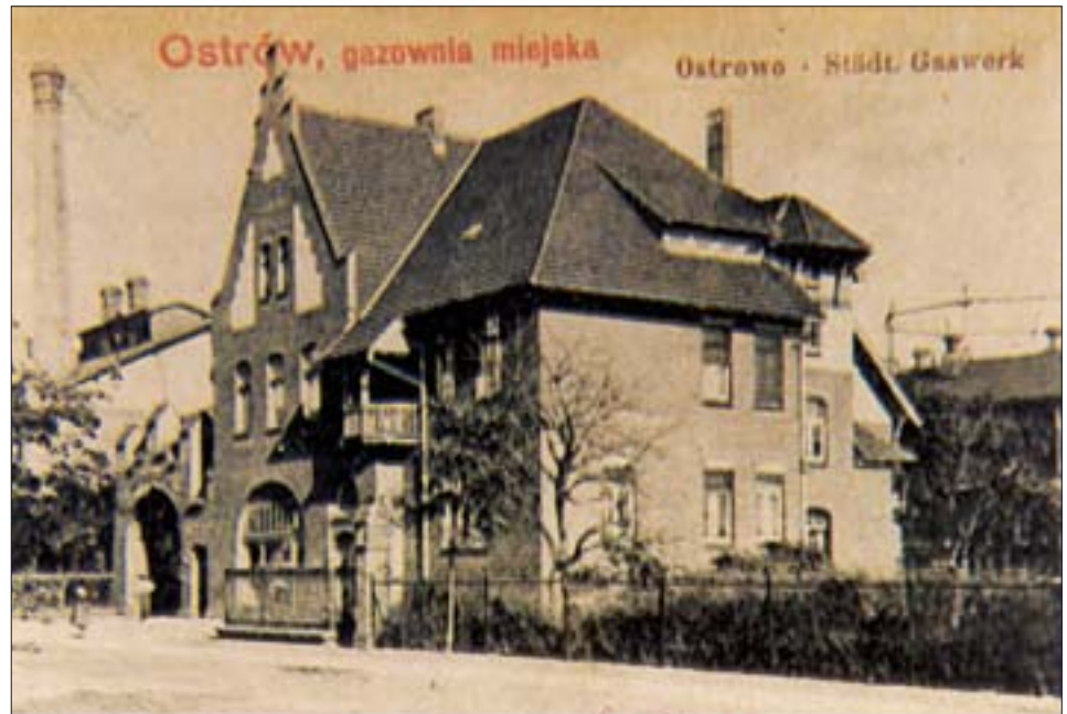
6. Zespół gazowni miejskiej w Ostrowie Wielkopolskim. Fotografia z pocz. XX w. 6. Municipal gas-works complex in Ostrow Wielkopolski. Photograph from the early twentieth century.
