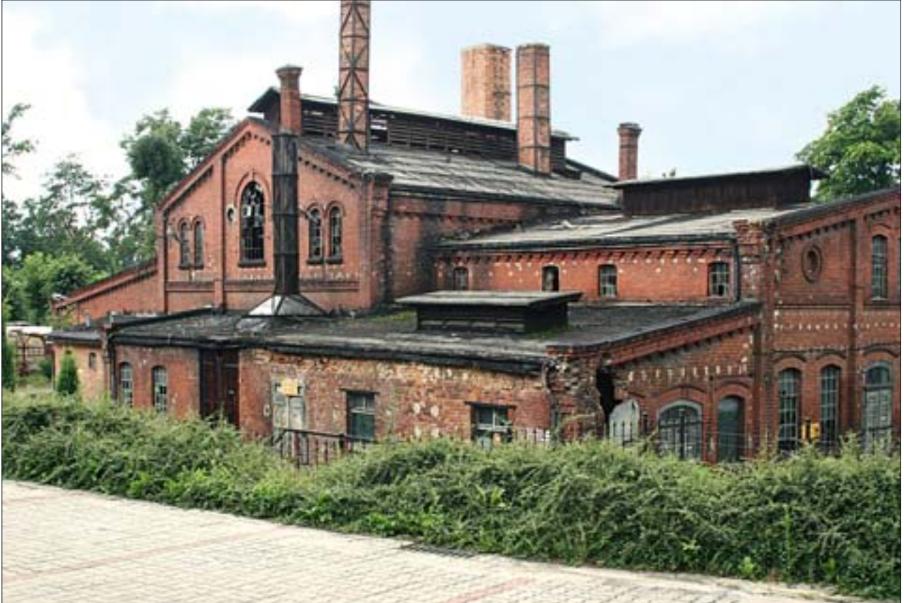
4. Nieużytkowana gazownia w Czarnkowie, 2004 r. Fot. T. Palacz. 4. Unused gas-works in Czarnków, 2004. Photo: T. Palacz.
