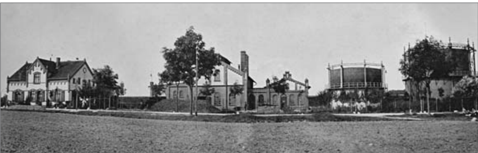
10. Zespół gazowni miejskiej w Jarocinie. Fotografia z pocz. XX w. 10. Municipal gas-works complex in Jarocin. Photograph from the early twentieth century.
