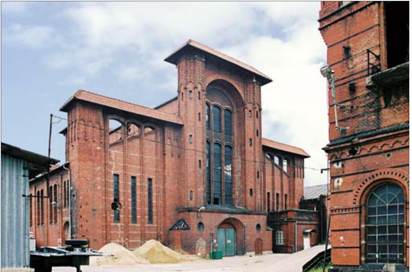
1. Kotłownia w zespole gazowni miejskiej w Poznaniu przy ul. Grobli, 2004 r. Fot. T. Palacz. 1. Boiler-room in the municipal gas-works complex in Grobli Street, Poznań, 2004. Photo: T. Palacz.
