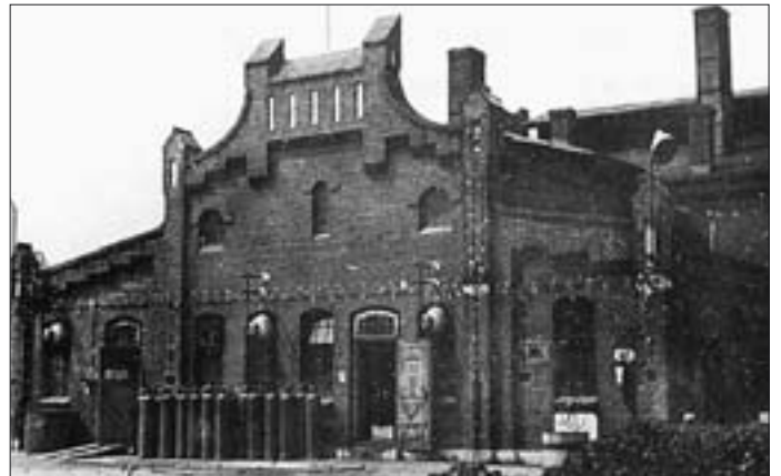
9. Gazownia w Ostrzeszowie, lata 70. XX w. 9. Gas-works in Ostrzeszów, 1970s.
