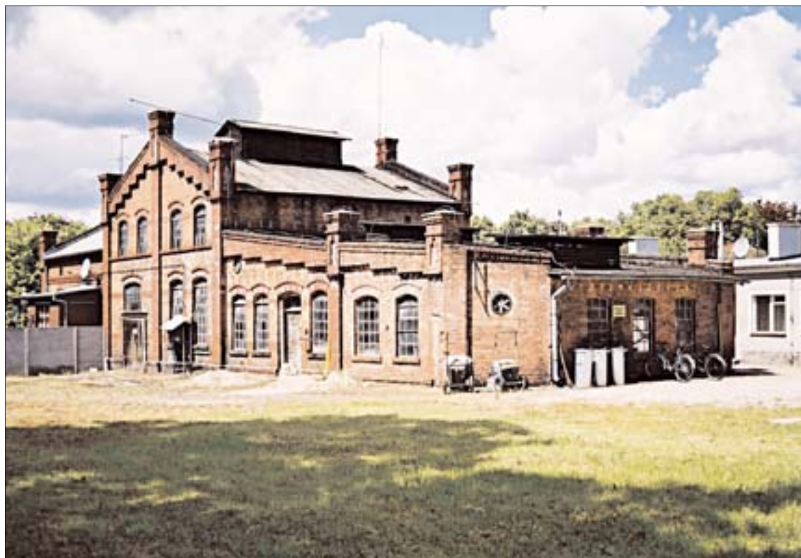
19. Nieużytkowana w części produkcyjnej gazownia w Rakoniewicach, 2004 r. Fot. T. Palacz. 19. Unused production part of the gasworks in Rakoniewice, 2004. Photo: T. Palacz.
