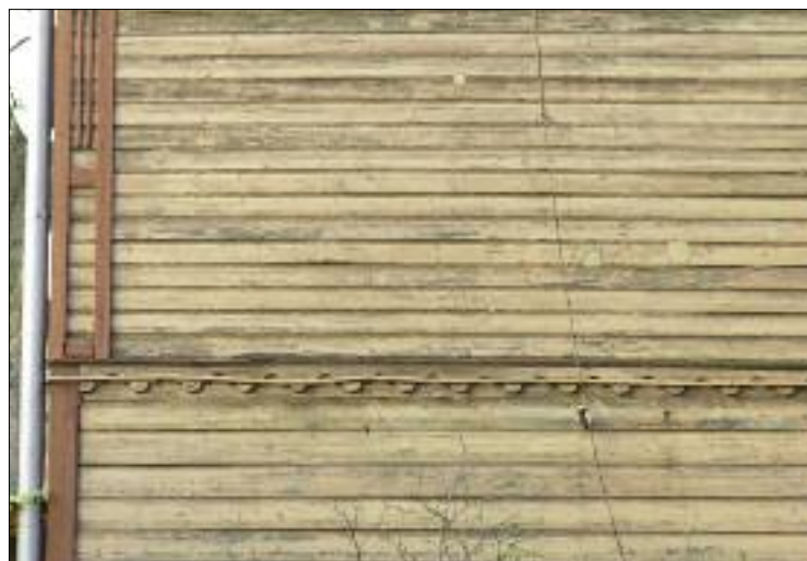
12. Otwock, ul. Kościuszki 35, 2. dziesięciolecie XX w., rozbudowa – 1931-1932 r. A – widok na elewację zachodnią, B – fragment szalunku na styku kondygnacji. Etapy budowlane wyróżnia układ deskowania i szerokość deski szalunkowej. W poziomym szalunku dolnej kondygnacji deski półwałkowe z obustronnym fazowaniem mają w licu szerokość od 15 do 17 cm; naroża ozdobiono deskami o fazowanych krawędziach. W nadbudowanym piętrze powtórzono kierunek deskowania, ale w bocznych polach szczytu oraz w elewacjach dobudowanej werandy szalunek ma już układ skośny – w jodelkę i romby, użyto też szalówki o szerokości 11 cm, ozdabiając narożniki budynku listwami imitującymi pilaster, 2007 r.
