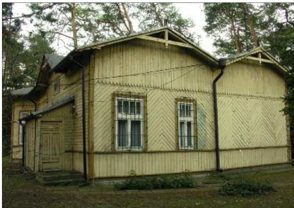
7. Otwock, ul. Prusa 5/9, willa Epsztainów, lata 20. XX w., rozbudowa wg projektu K. Meissnera – 1930 r. Widok na elewację północną, 2006 r. 7. Otwock, 5/9 Prusa Street, the Epsztain villa, 1920s, expanded according to a design by K. Meissner – 1930. View of the northern elevation, 2006.
