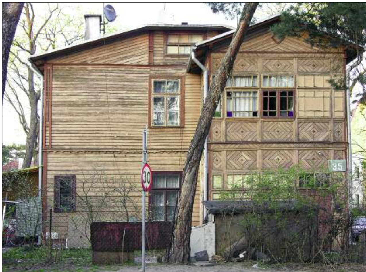
12. Otwock, ul. Kościuszki 35, 2. dziesięciolecie XX w., rozbudowa – 1931-1932 r. A – widok na elewację zachodnią, B – fragment szalunku na styku kondygnacji. Etapy budowlane wyróżnia układ deskowania i szerokość deski szalunkowej. W poziomym szalunku dolnej kondygnacji deski półwałkowe z obustronnym fazowaniem mają w licu szerokość od 15 do 17 cm; naroża ozdobiono deskami o fazowanych krawędziach. W nadbudowanym piętrze powtórzono kierunek deskowania, ale w bocznych polach szczytu oraz w elewacjach dobudowanej werandy szalunek ma już układ skośny – w jodelkę i romby, użyto też szalówki o szerokości 11 cm, ozdabiając narożniki budynku listwami imitującymi pilaster, 2007 r.
