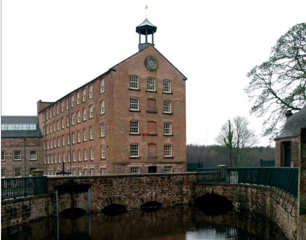
3. Młyn Stanley podczas prac konserwatorskich. Źródła archiwalne ujawniły lokalne pochodzenie cegieł użytych do budowy młyna (ze zbiorów Historic Scotland).
