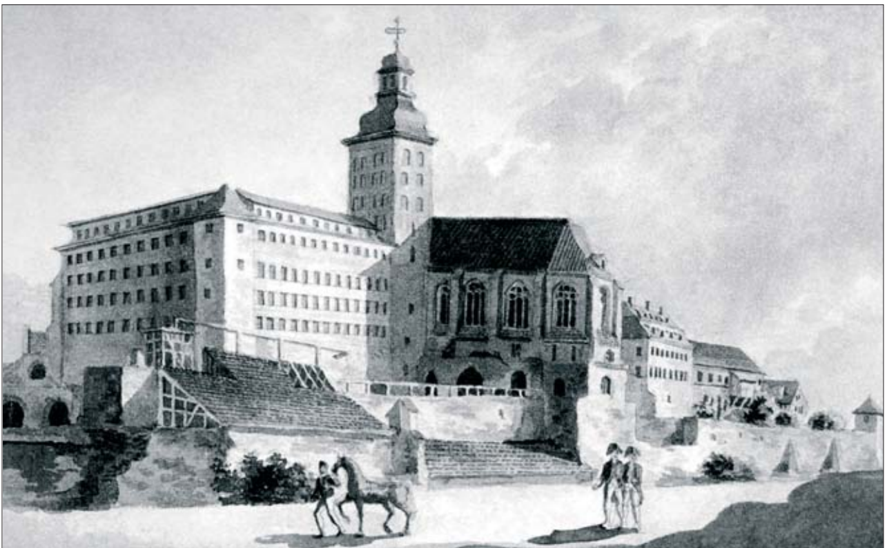
3. Widok zamku od południowego wschodu, 1802. Zwracają uwagę liczne otwory okienne, przebudowane dachy, brak fortyfikacji. Po prawej stronie bryła kolegium jezuickiego. Ściany zewnętrzne zostały wówczas otynkowane. Autor nieznany, repr. z: M. Kilariski, Odbudowa i konserwacja zespołu zamkowego w Malborku w latach 1945-2000 , Malbork 2007, s. 15.
