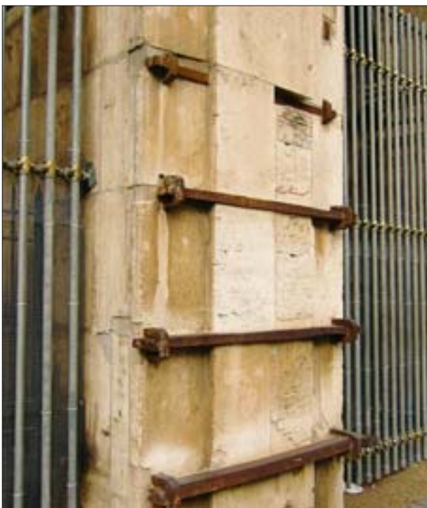
9. Koloseum, stare wzmocnienia w formie żelaznych obejm. 9. Colosseum, old reinforcements in the shape of iron braces.
