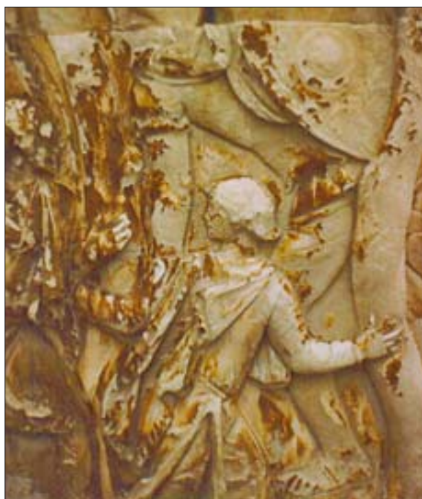
2. Fragment dekoracji rzeźbiarskiej kolumny Trajana w trakcie prac konserwatorskich w 1984 r., widoczne fragmenty starych powłok ochronnych.
