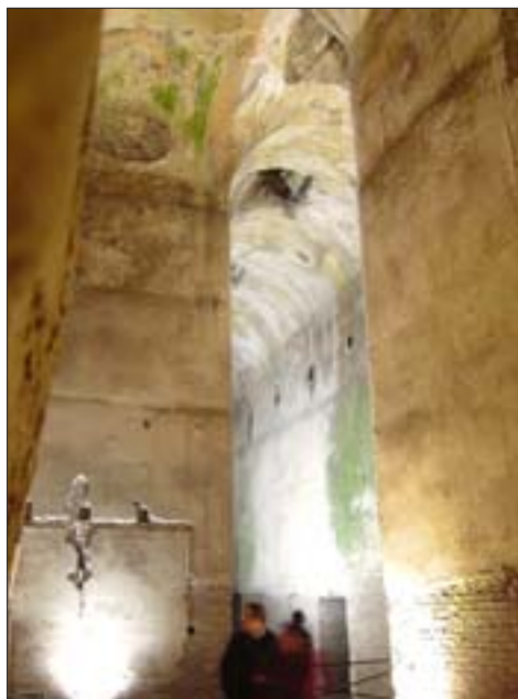
25. Domus Aurea, kryptoportyk, widoczne objawy korozji biologicznej (glony), wysolenia i zacieki związane z penetrującą do wnętrza wodą opadową.
