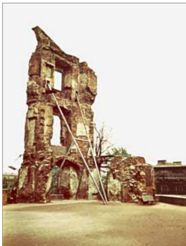
4. Warszawa. Fragment ruin zamku przed jego odbudową. Przykład tymczasowego (odwracalnego) zabezpieczenia konstrukcyjnego w formie podparcia ze stalowych rur. Fot. J. Tajchman. 4. Warsaw. Fragment of the Royal Castle ruins prior to reconstruction. Example of temporary (reversible) construction protection in the form of steel pipe supports. Photo: J. Tajchman.
