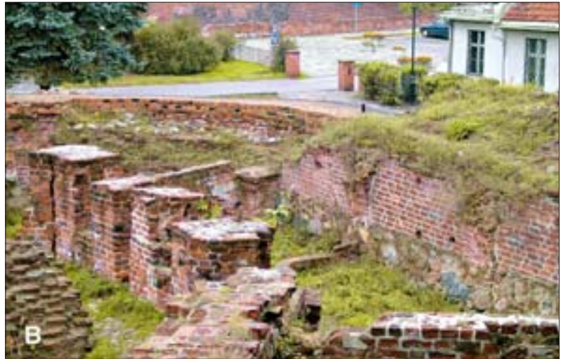
32. Toruń. Ruiny zamku krzyżackiego. A – malowniczy fragment murów przed zabezpieczeniem korony, 1964 r. Fot. J. Tajchman; B – ten sam fragment murów po pracach. Przykład usztywnienia korony mimo dążenia do jak najmniejszej ingerencji w substancję zabytkową. Po latach malowniczość obiektu poprawiła samorodna zieleń, 2003 r. Fot. E. Okoń.
