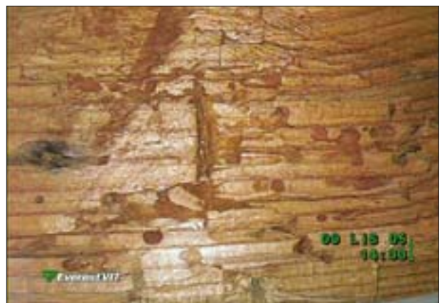
3. Żerowisko owadów w belkach stropowych nad Pokojem Chińskim w Pałacu w Wilanowie, obraz z videoendoskopu. Fot. P. Witomski. 3. Insects feeding ground in floor beams over the Chinese Room at Wilanów Palace, seen in a videoendoscope. Photo: P. Witomski.
