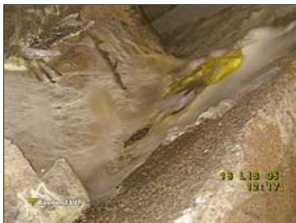
6. Wnętrze stropu przyziemia z grzybnią strocza łzawego, obraz z kamery endoskopu. Fot. P. Witomski.
