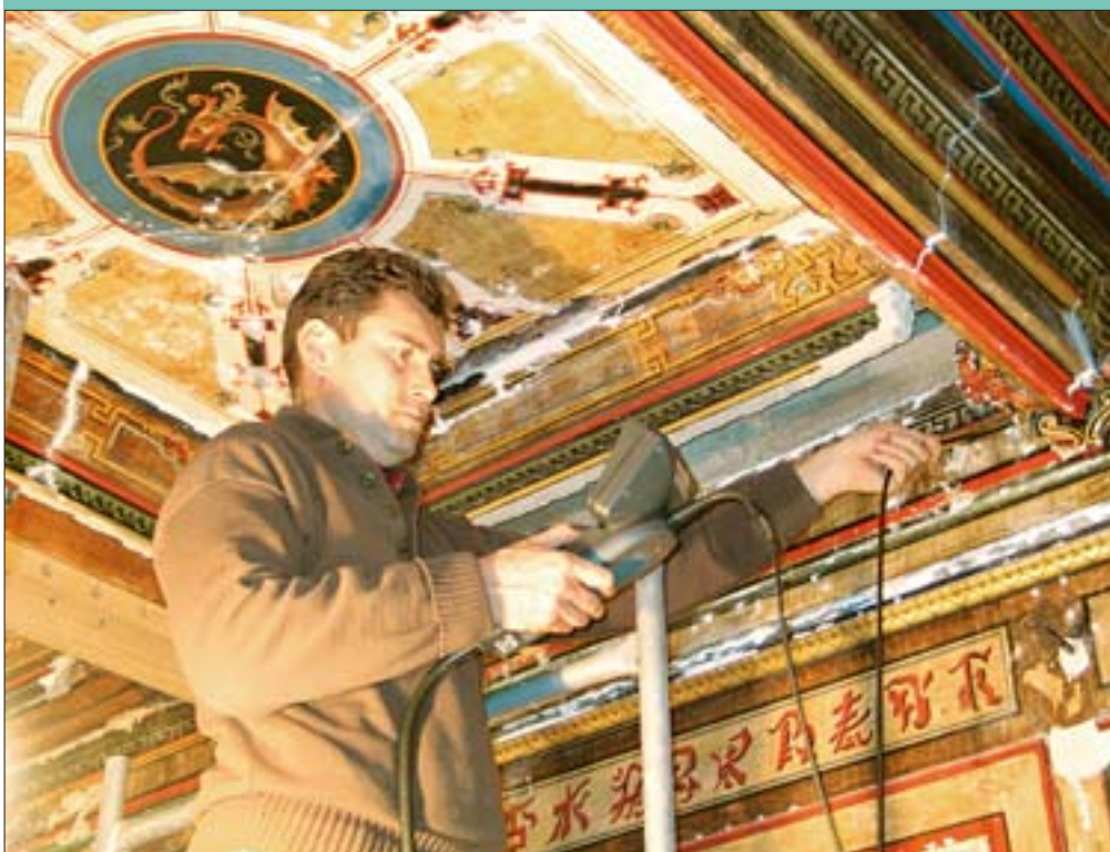
2. Badania wnętrza stropu w Pokoju Chińskim w Pałacu w Wilanowie. Fot. A. Krajewski. 2. Examination of the interior of the Chinese Room ceiling in Wilanów. Photo: A. Krajewski.
