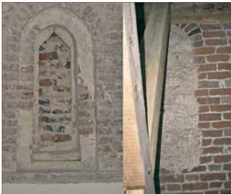
11. Odsłonięte okno wschodnie ściany północnej nawy z relikdami szklenia szkłem gomółkowym.
