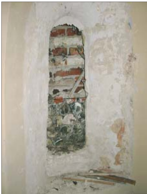
11. Odsłonięte okno wschodnie ściany północnej nawy z relikdami szklenia szkłem gomółkowym.
