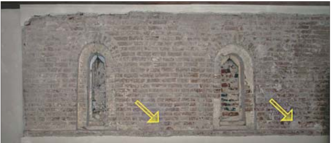
10. Zamurowane wnęki w ścianie północnej nawy romańskiej, być może ślad otwartej więźby dachowej lub wsparcia pierwotnego stropu. 10. Walled up niches in the northern wall of the Romanesque nave, possibly the trace of an open roof truss or the support of the original ceiling.
