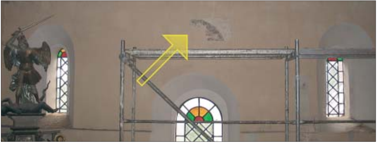
9. Odsłonięte, częściowo skute nadproże okna środkowego ściany południowej nawy. 9. Partially disclosed lintel of the central window in the southern nave.
