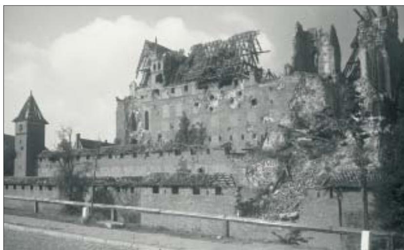
8. Malbork, widok zamku w ruinie, 1945 r. Fot. E. Falkowski. 8. Malbork, view of the castle ruins, 1945. Photo: E. Falkowski.
