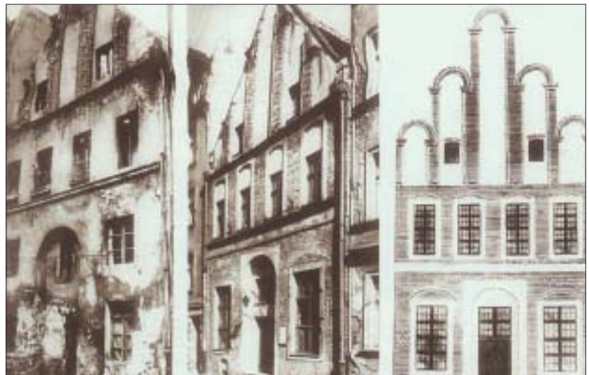
5. Fasada kamienicy przy ul. Franciszkańskiej 12 w Toruniu. Od lewej: stan przed 1985 r., stan po przeprowadzeniu prac konserwatorskich, teoretyczna rekonstrukcja stanu z 1. poł. XVI w. 5. Façade of a town house in 12 Franciszkańska Street in Toruń. From the left: state prior to 1985, state after conservation, theoretical reconstruction of the state from the first half of the sixteenth century.
