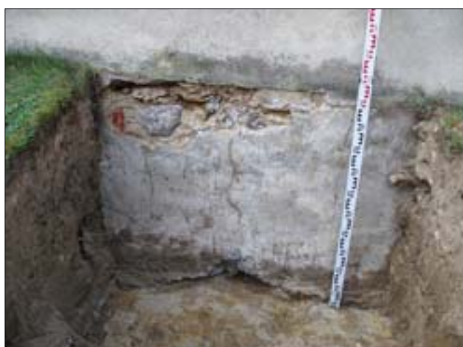
19. Wykop nr 4. 19. Dig no. 4.
