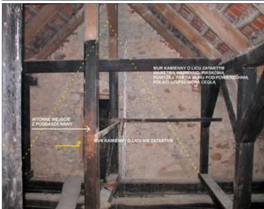
11. Strych nad prezbiterium ściana zachodnia z odciskami pierwotnej więźby. 11. Attic over the presbytery – the western wall with traces of the original roof truss.
