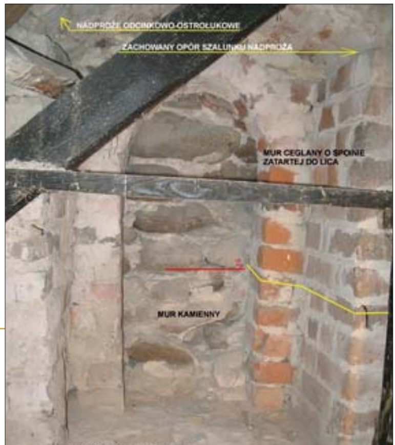
8a. Strych nad nawą zamurowane okno pierwotnej nawy w ścianie tęczowej od strony północnej. Widok z poddasza nawy.
