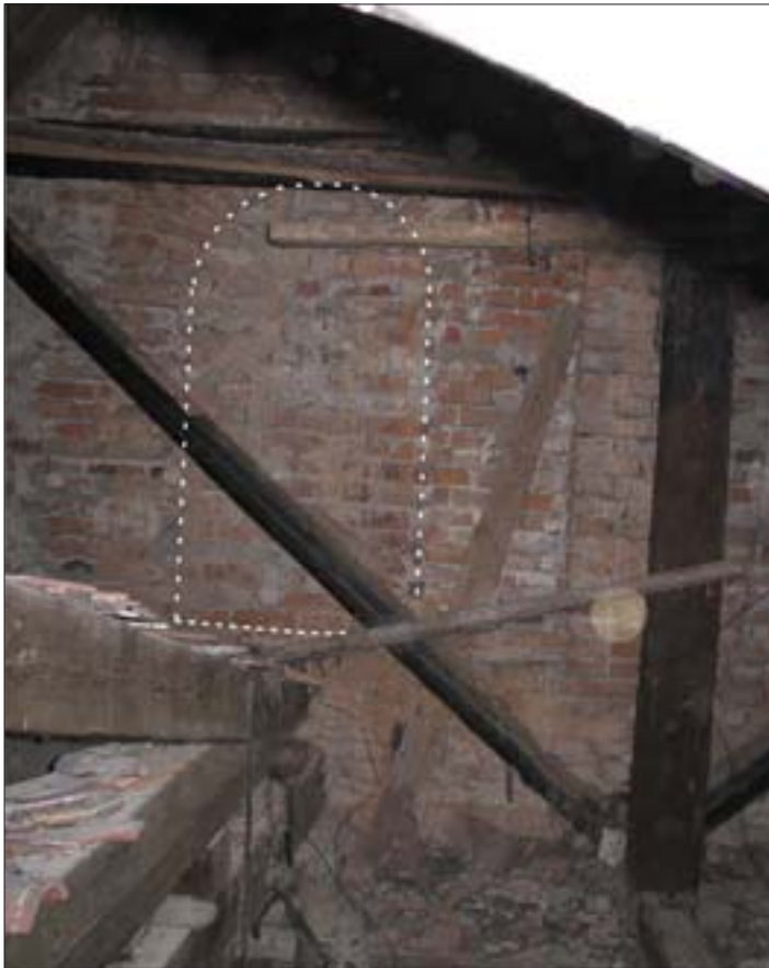
7. Ściana zachodnia, widok od strony strychu nad nawą. Widoczny zamurowany otwór zwieńczony półkolistym nadprożem.
