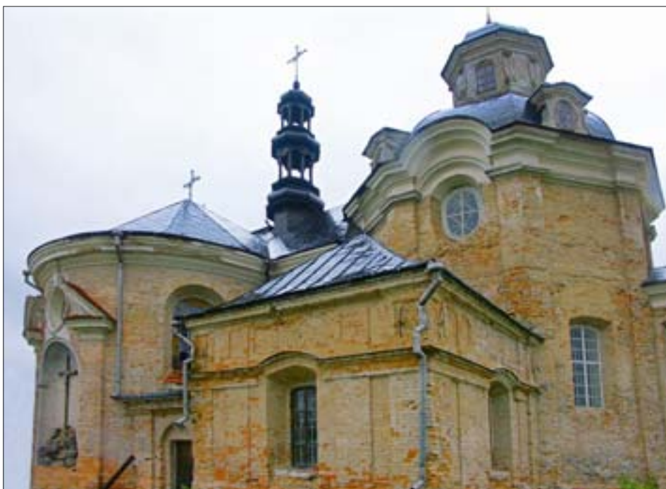
3. Kościół pw. św. Antoniego w Korcu.
