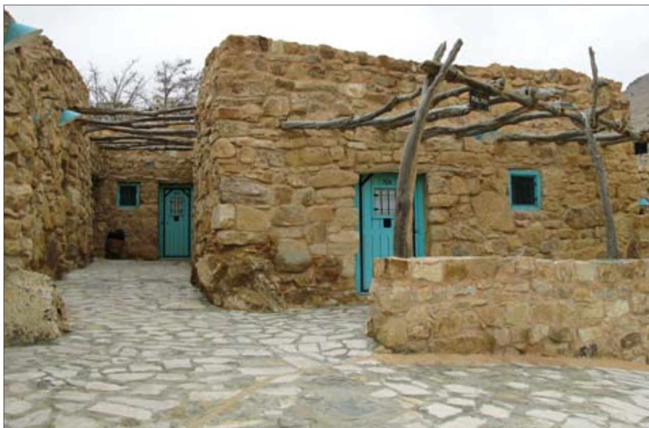
10. Tradycyjne drewniane konstrukcje: niegdyś chroniły przed słońcem, dziś stanowią element dekoracyjny. 10. Traditional wooden construction used to offer protection from the sun now comprises a decorative element.
