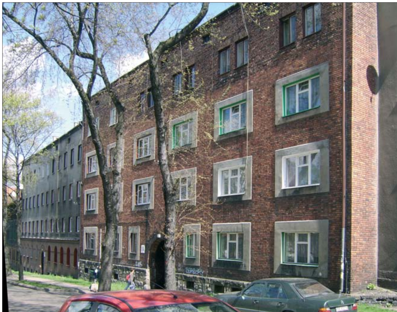
3. Nadbudowane domy przy ul. Barbary 10 i 12. 3. Added houses in 10 and 12 Barbary Street.
