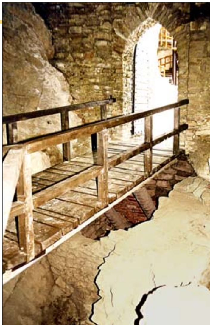
34. Pomosty w przyziemiu Baszty Baranowskiego umożliwiające przejście na zamek średni, a jednocześnie ekspozycję relikwii gotyckiego przedbramia. Konstrukcja żelbetowa z drewnianym pomostem i balustradami. W głębi gotycki otwór bramny. Fot. P. Stępień, 2000 r.
