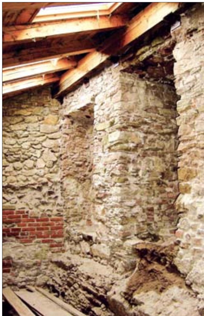
33. Wnętrze Ziełenica w trakcie prac zabezpieczających, okna polaciowe zastosowane do oświetlenia istotnych elementów struktury zabytkowej (wnęki w murze tarczowym). Fot. P. Stępień, 2004 r.
