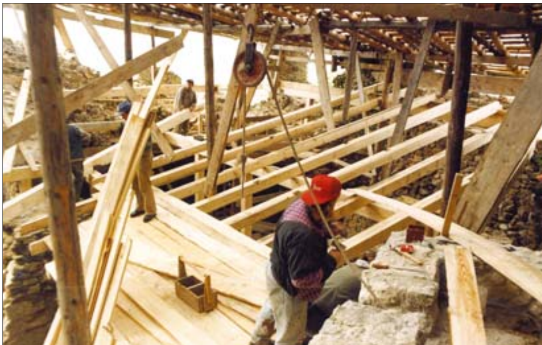
25. Montaż zadaszenia o konstrukcji drewnianej nad zamkiem średnim. Fot. P. Stępień, 1998 r. 25. Assembling a wooden roof above the Middle Castle. Photo: P. Stępień, 1998.
