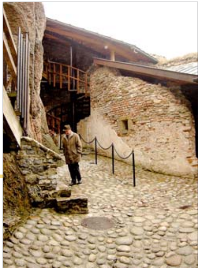
32. Dziedziniec zamku średniego po pracach zabezpieczających, w głębi spiralna klatka schodowa usytuowana w relikwach schodów XVII-wiecznych. Fot. P. Stępień, 2003 r.
