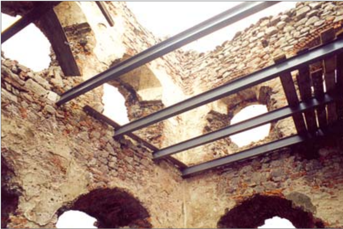
31. Montaż stalowych belek stropowych w poziomie II piętra Baszty Baranowskiego. Fot. P. Stępień, 2002 r.
