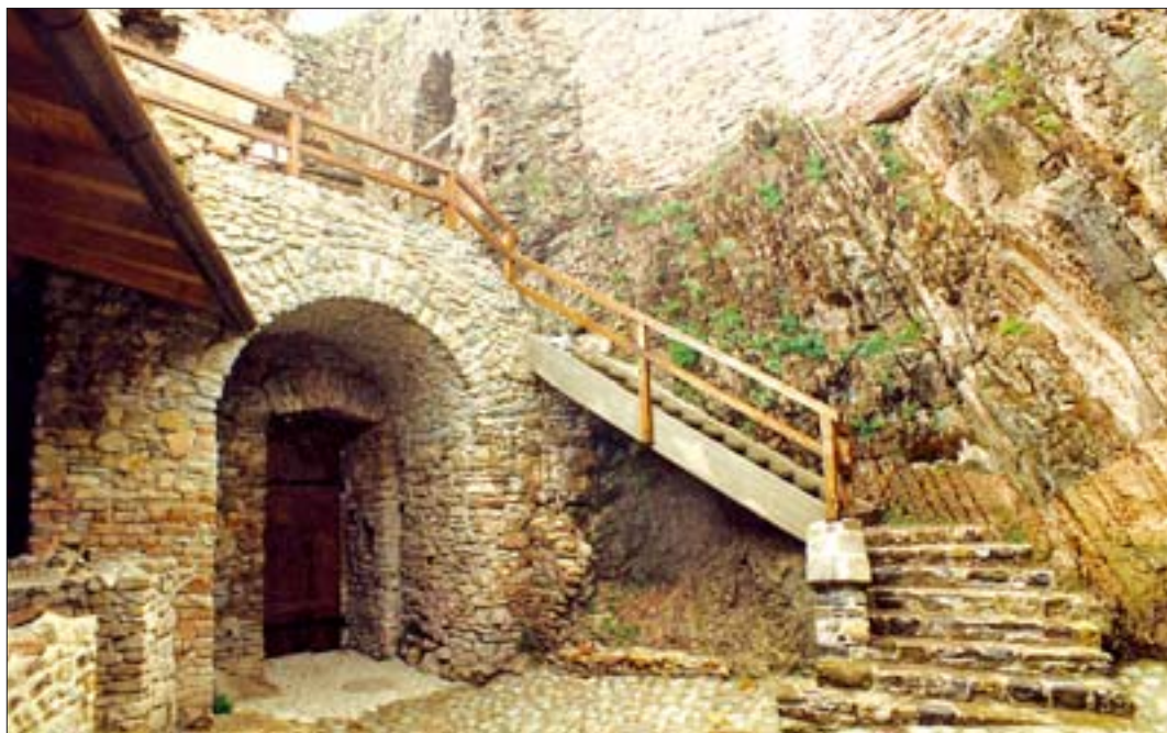
27. Schody na ganek przy Baszcie Baranowskiego, odtworzone w historycznym miejscu z zastosowaniem współczesnej konstrukcji. Fot. P. Stępień, 1999 r. 27. Stairs to the porch of the Baranowski Bastion, recreated in their historical location and assembled with the application of contemporary construction. Photo: P. Stępień, 1999.
