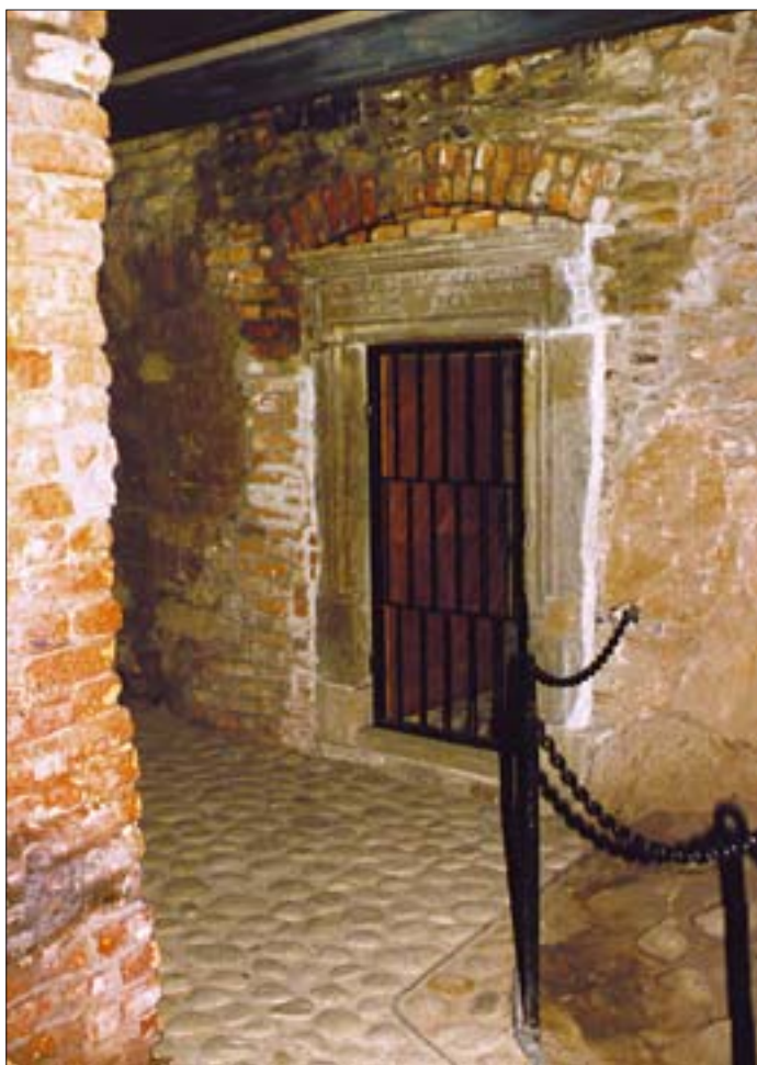
22. Sień zamku górnego po konserwacji, po prawej odgródzone łańcuchem relikty oryginalnego bruku z otoczeków, w głębi portal z 1640 r., zmontowany z oryginalnych fragmentów odnalezionych w gruzie wypełniającym pomieszczenie. Fot. P. Stępień, 1996 r. 22. Upper Castle hallway after conservation; to the right: relics of the original pavement fenced by a chain, in the background: portal from 1640, assembled out of original fragments found in the rubble filling the interior. Photo: P. Stępień, 1996.
