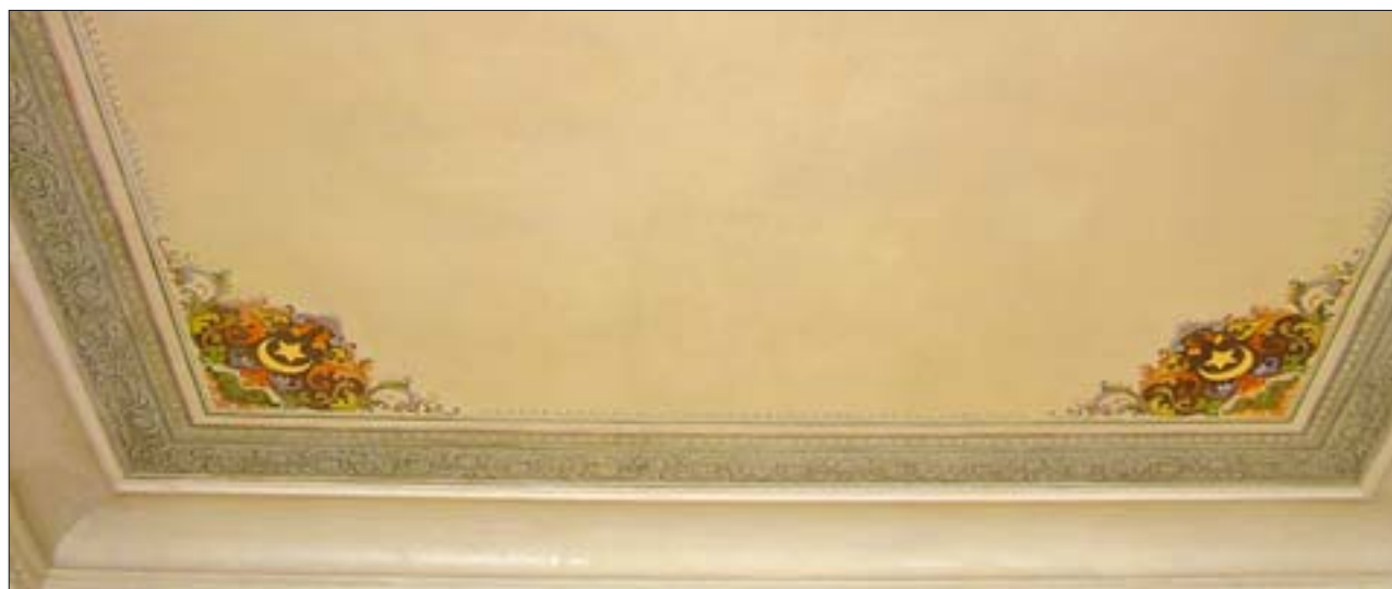
14. Pomieszczenie nr 5 po zamontowaniu wszystkich uratowanych fragmentów dekoracji malarskiej i sztukatorskiej. Rekonstrukcja ubytków tynku i polichromii pozwoliła na odtworzenie pierwotnego wyglądu pomieszczenia.
