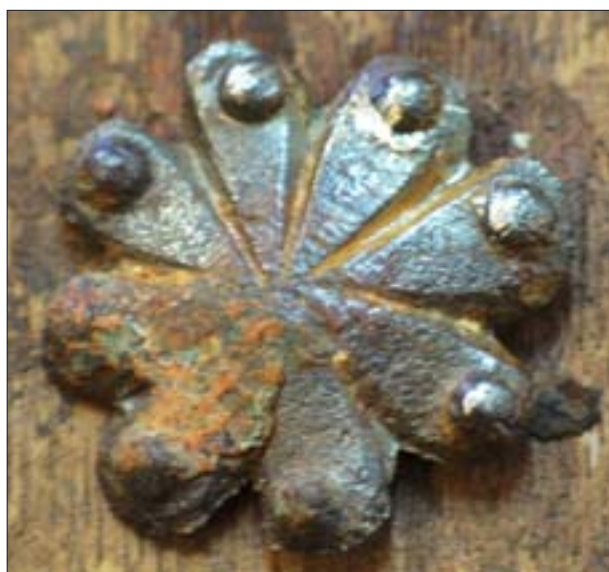
8. Widoczny zachowany fragment cynowania na łebku gwoźdźcia z drzwi z kościoła św. Jana. Stan w trakcie prac konserwatorskich, sierpień 2005 r. Fot. K. Darecka.
