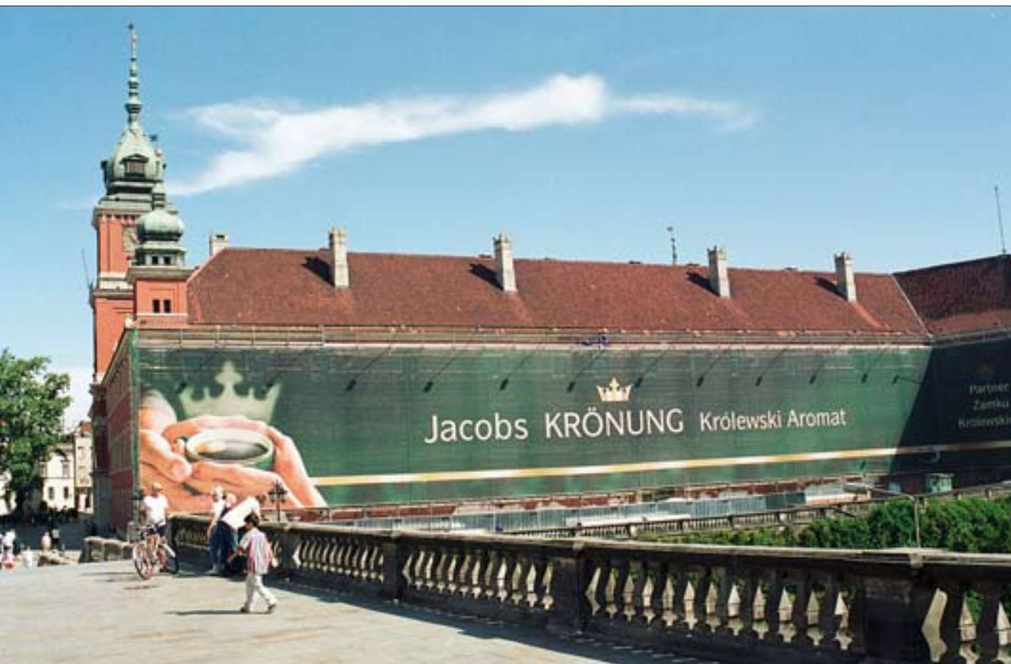
2. Warszawa, Zamek Królewski w trakcie remontu elewacji. Fot. archiwum KOBIDZ.
