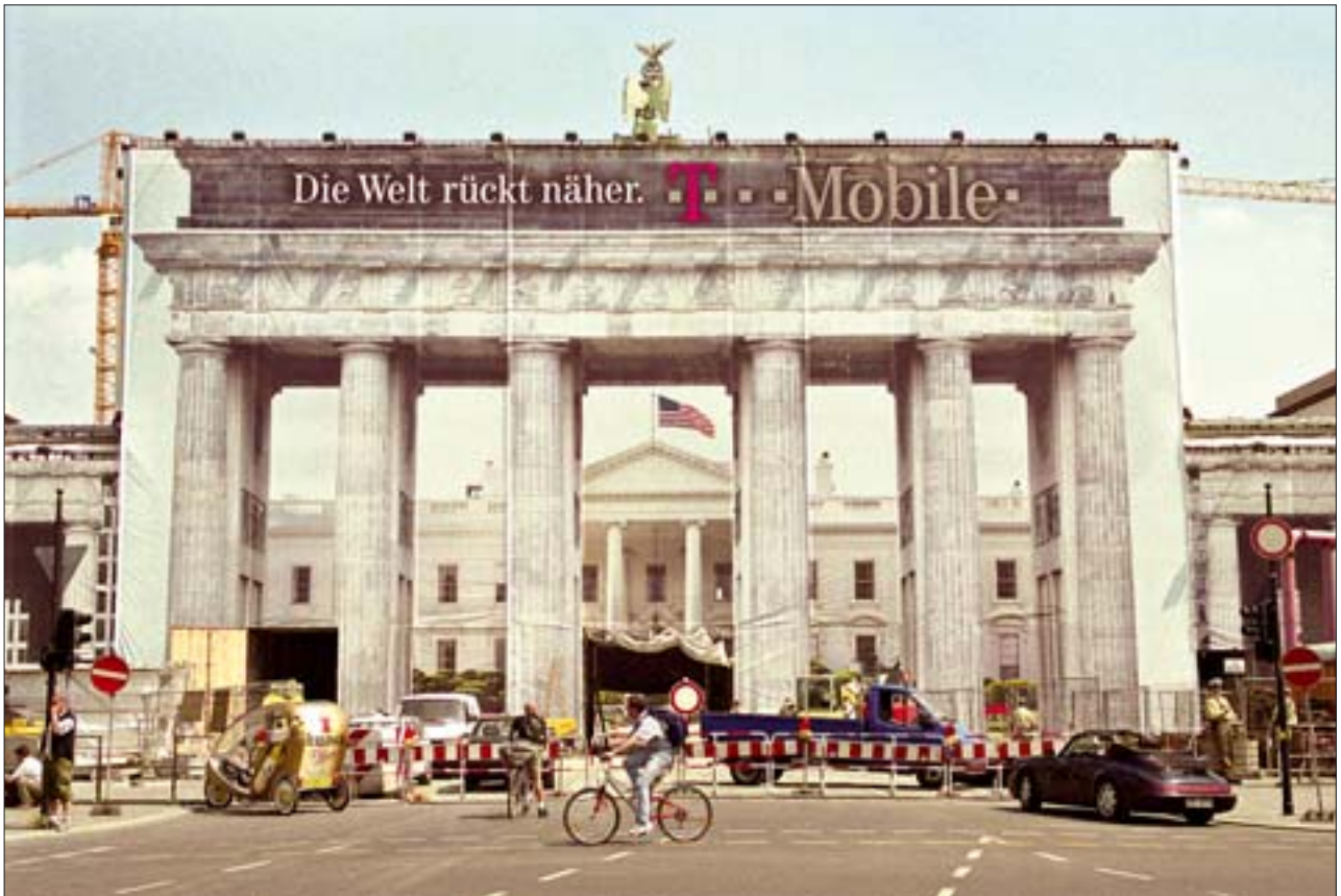
11. Berlin, Brama Brandenburska w czasowej reklamie odwzorowującej elewację. Fot. H. Burkhardt, Lilano.com 11. Berlin, Brandenburg Gate in a temporary advertisement that reproduces the elevation. Photo: H. Burkhardt, Lilano.com
