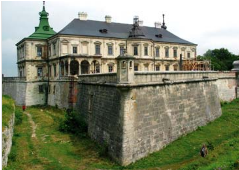
1. Pałac w Podhorcach. Stan z 2004 r. Fot. K. Czajkowski.
