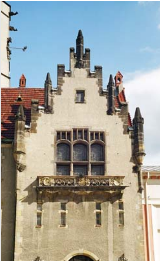
8. Fragment zachodniego ryzalitu fasady ratusza z widocznym oknem Sali Rajców. Fot. E. Rdzawska, 2004 r. 8. Fragment of the western projection of the town hall facade with a visible window of the councillors' hall. Photo: E. Rdzawska, 2004.
