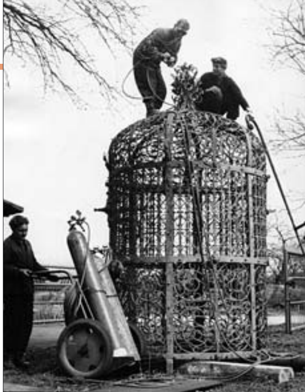
7. Prostowanie kraty Pięknej Studni. Fot. Z. Kwiecień, 1968 r.
