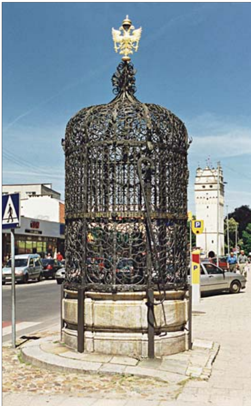
1. Piękna Studnia w Nysie przed ostatnią konserwacją. Fot. Z. Walewski, 2005 r.
