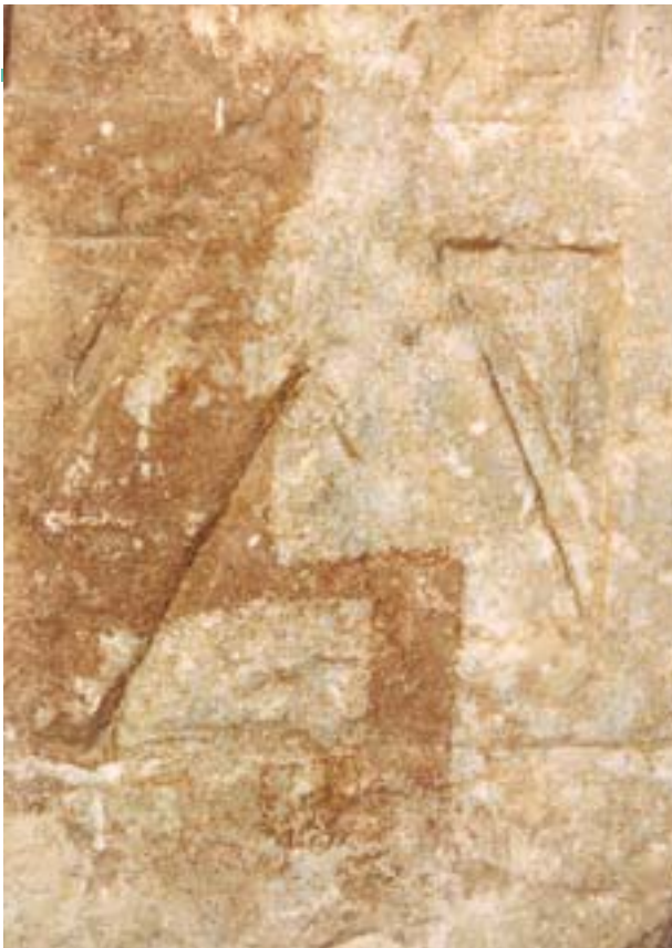
4. Nawarstwienia krzemianowo-kalcytowo-gipsowe w trakcie usuwania urządzeniem ReNOVALaser 2.
