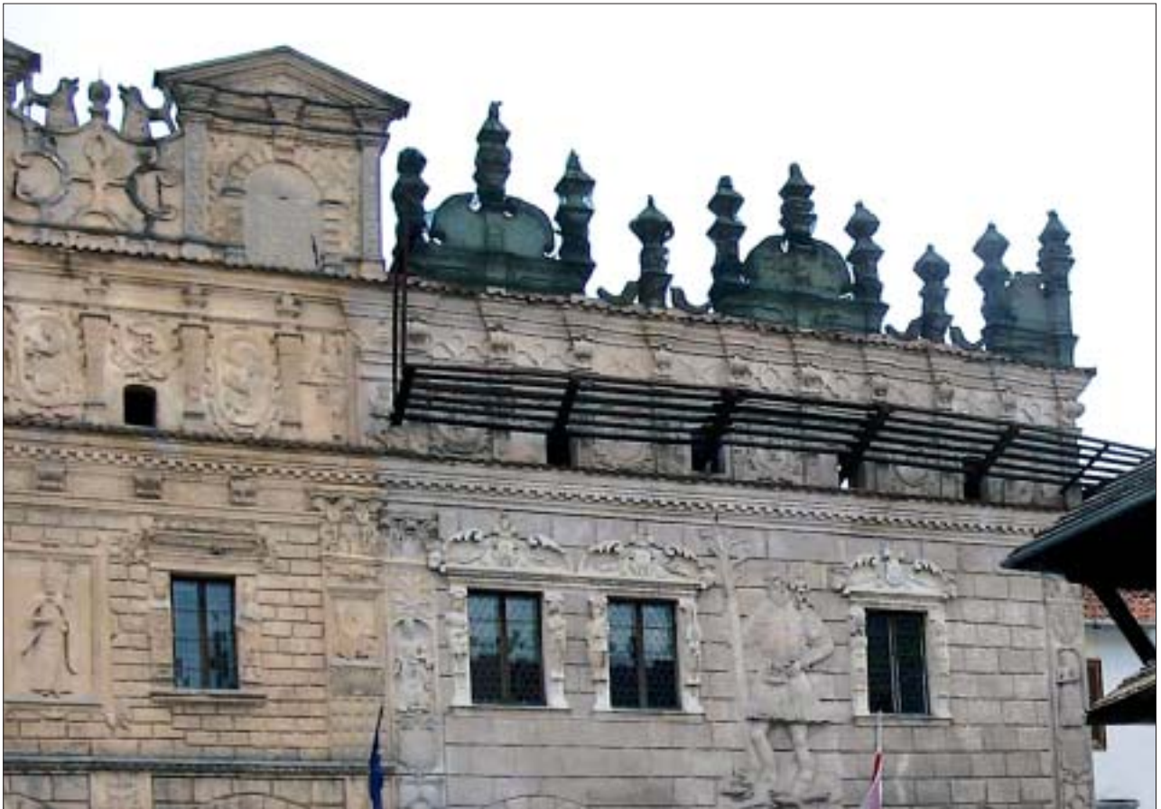
8. Kamienice Przybyłów. Szczyt kamienicy Krzysztofa Przybyły został osłonięty, by ochronić przechodniów przed odpadającymi elementami sztukaterii. Fot. B. Szmygin.
