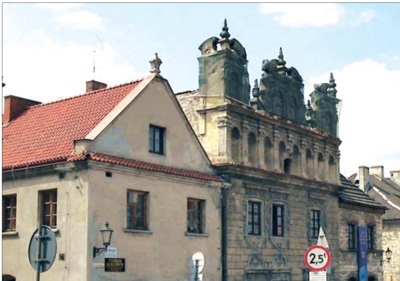
9. Kamienica Celejowska (siedziba Muzeum Nadwiślańskiego) – szczyt kamienicy jest osłonięty, by ochronić przechodniów przed odpadającymi elementami sztukaterii. Fot. B. Szmygin.
