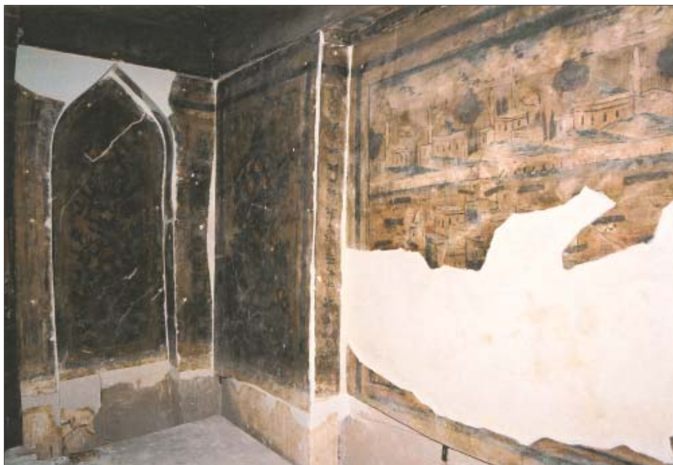
14. Ściana południowa salonu po zamontowaniu transferów, w trakcie uzupełniania ubytków tynku. Fot. M. Filip.
