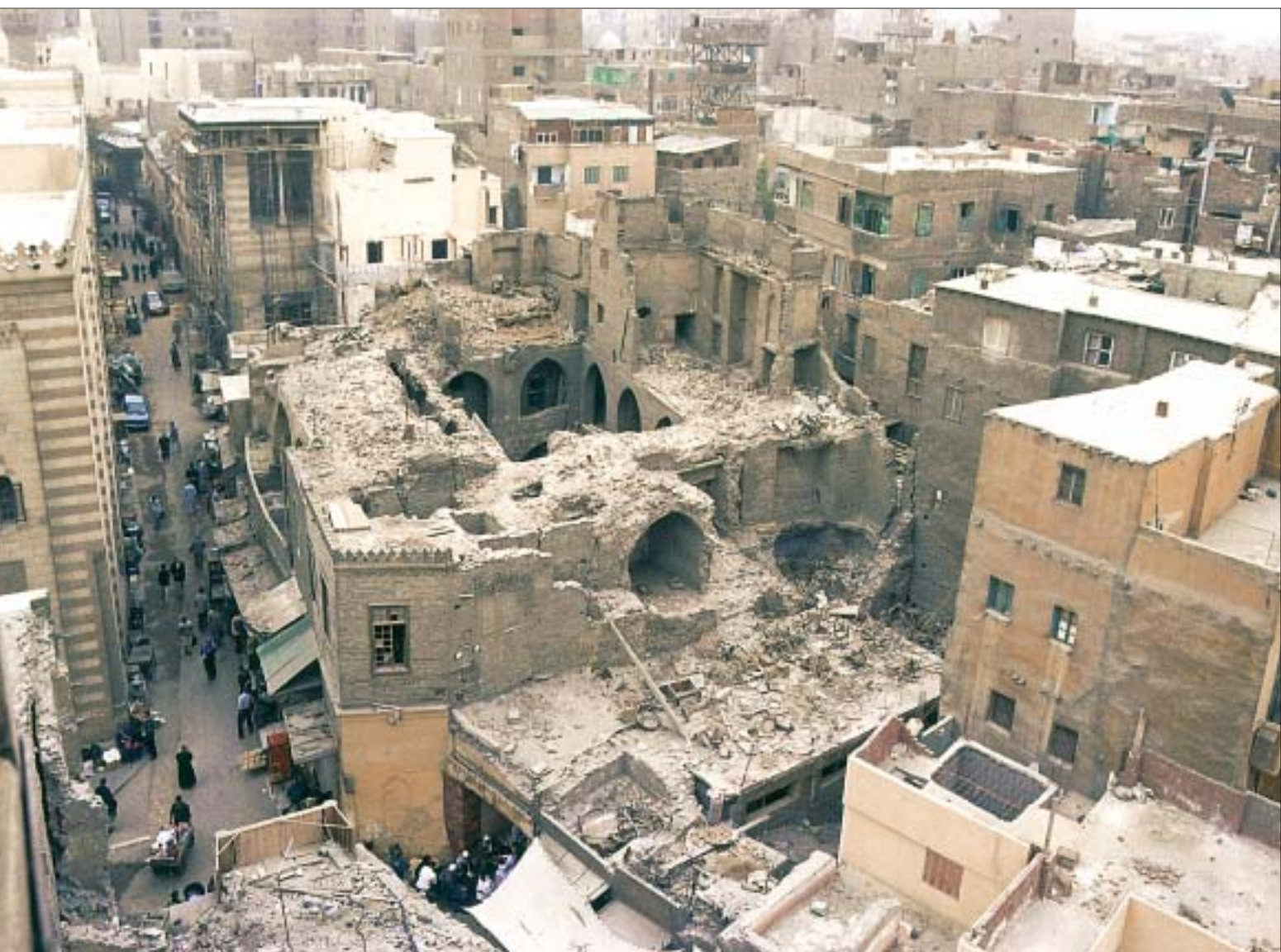
2. Zdewastowany budynek na terenie Historycznego Kairu. Fot. M. Filip.
