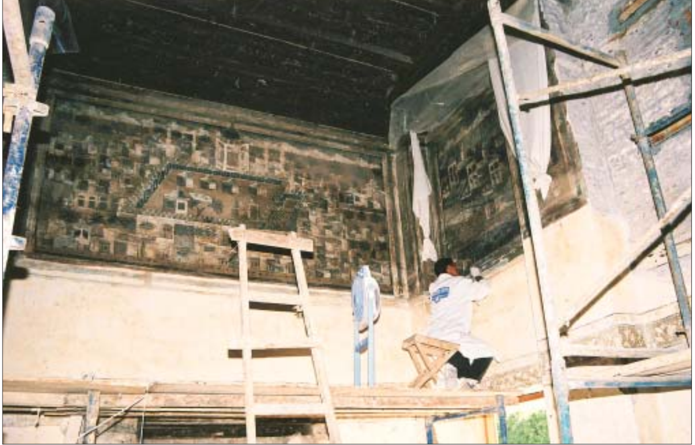
12. Dom Sitt Wasilli. Malowidła na ścianie północnej w trakcie konserwacji in situ . Fot. M. Filip. 12. The Sitt Wasilli House. Murals on the northern wall in the course of in situ conservation. Photo: M. Filip.
