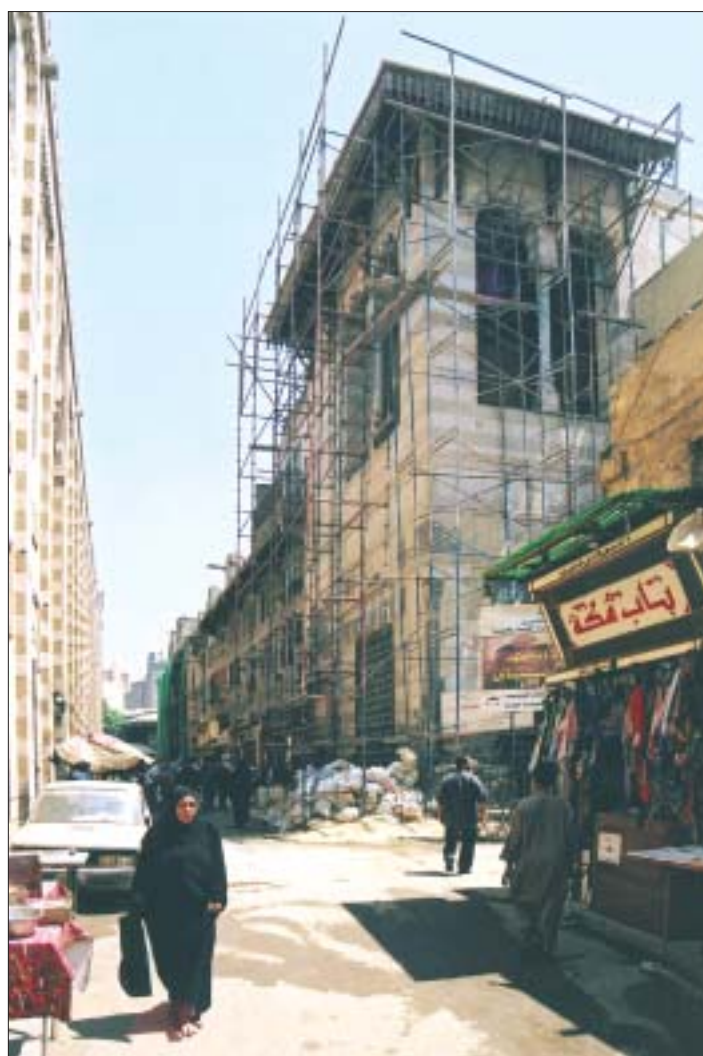
5. Ulica obok meczetu Al-Azhar w trakcie prac renowacyjnych. Fot. M. Filip.
