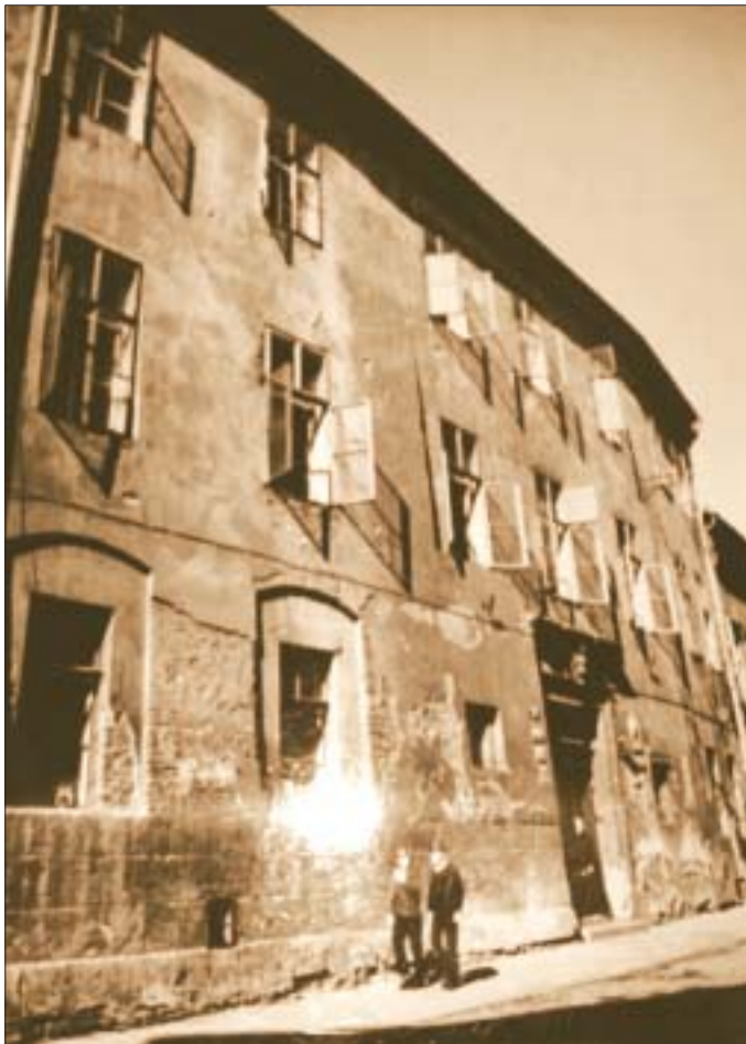
1. Stan elewacji pałacu od strony ulicy Kanoniczej (rok 1948). 1. State of the elevation of the Palace from Kanoniczna Street (1948).
