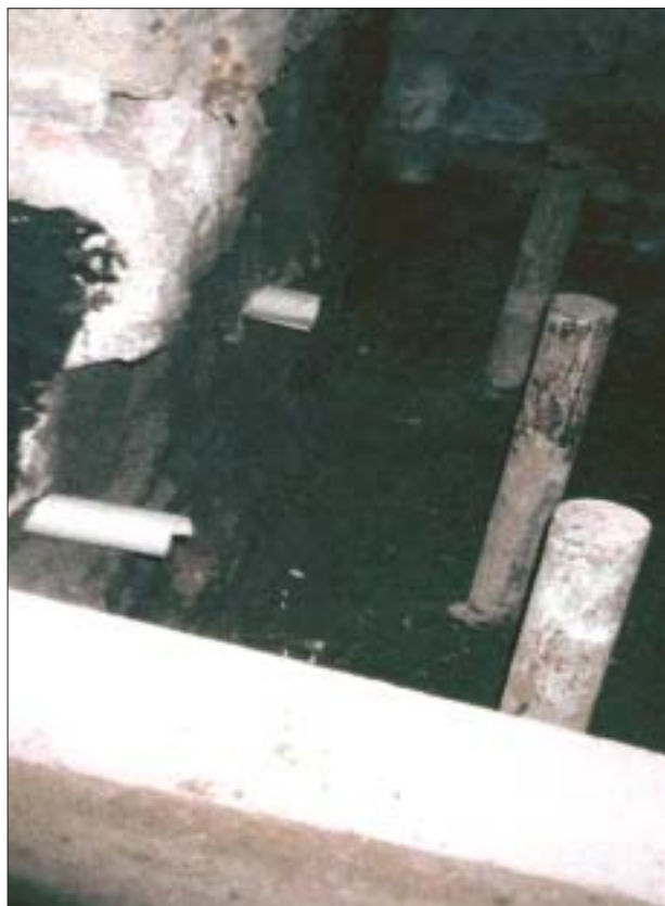
9. Wzmocnienie fundamentów pałacu za pomocą mikropali. 9. Reinforcement of Palace foundations with the help of micro-posts.
