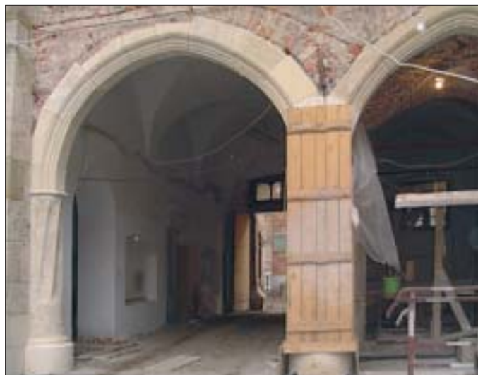
8. Pałac w trakcie rewaloryzacji. 8. Palace in the course of revalorisation.
