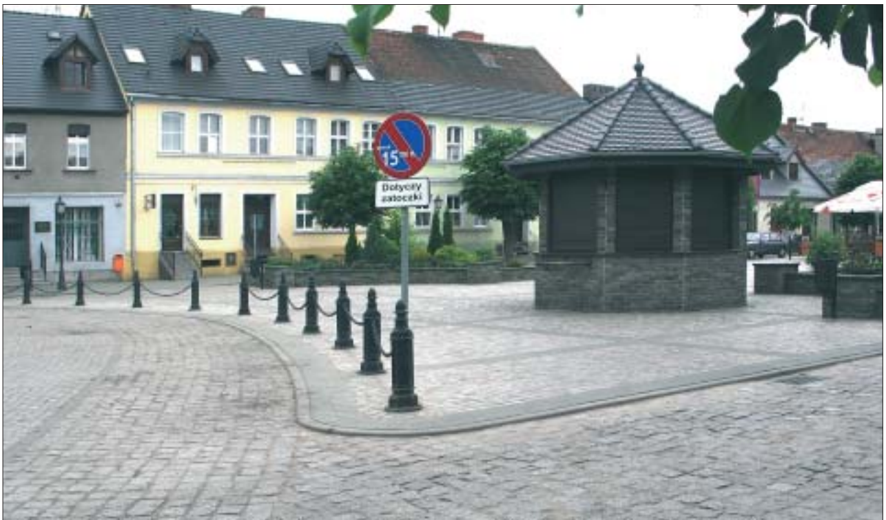
29. Rynek w Zbąszyniu po modernizacji. Widok od strony ul. Senatorskiej – kiosk, murki z zielenią. Fot. R. Banach, 2005 r. 29. Market square in Zbąszyn after modernisation. View from Senatorska Street – kiosk, walls with plants. Photo: R. Banach, 2005.
