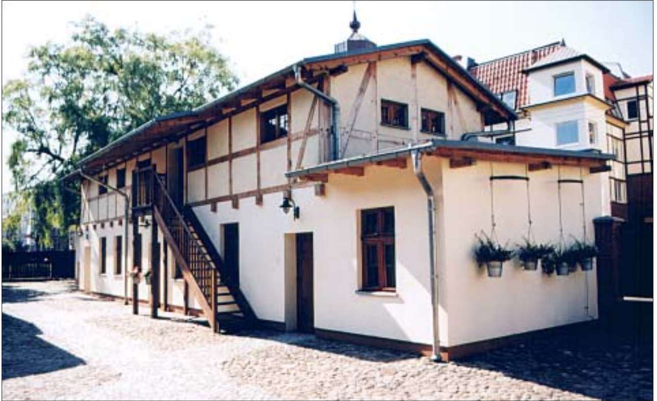
9. Zagroda bammerska na Jeżycach, zabudowania gospodarcze, stan obecny. Fot. A. Jabłońska. 9. Farmstead in Jeżyce, farm buildings, present-day state. Photo: A. Jabłońska.
