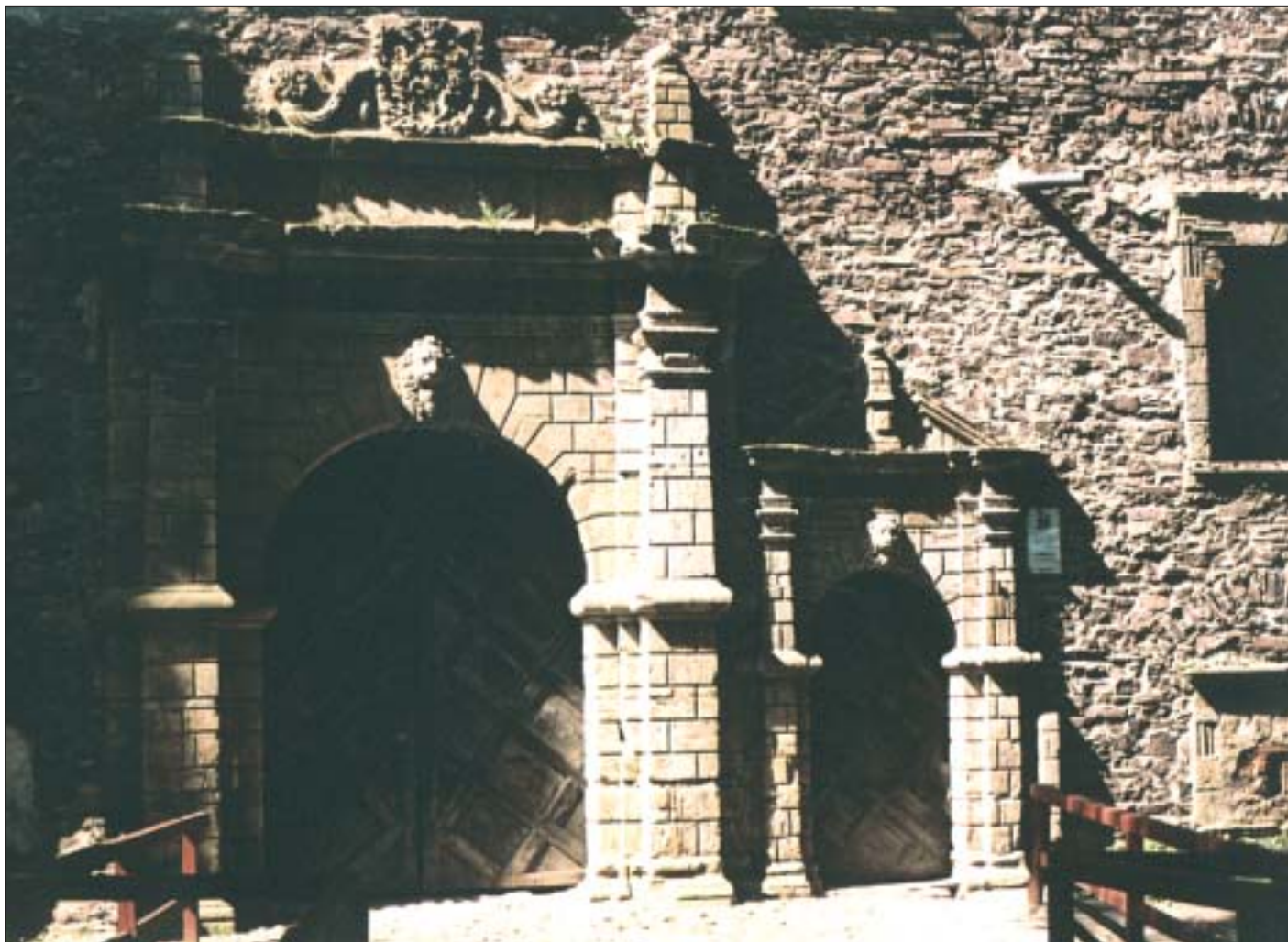
2. Portal bramy wjazdowej do zamku w Świnach, wykonany z kredowego piaskowca ciosowego. 2. Entrance gate portal in Świny Castle built out of hewn sandstone.
