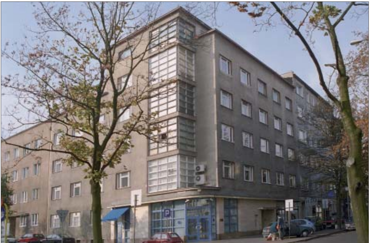
1. Gdynia, kamienica Tuchołki, ul. Armii Krajowej 9. Wszystkie fot. K. Babnis, 2001 r. 1. Gdynia, the Tuchołko town house, 9 Armii Krajowej Street. All photos: K. Babnis, 2001.
