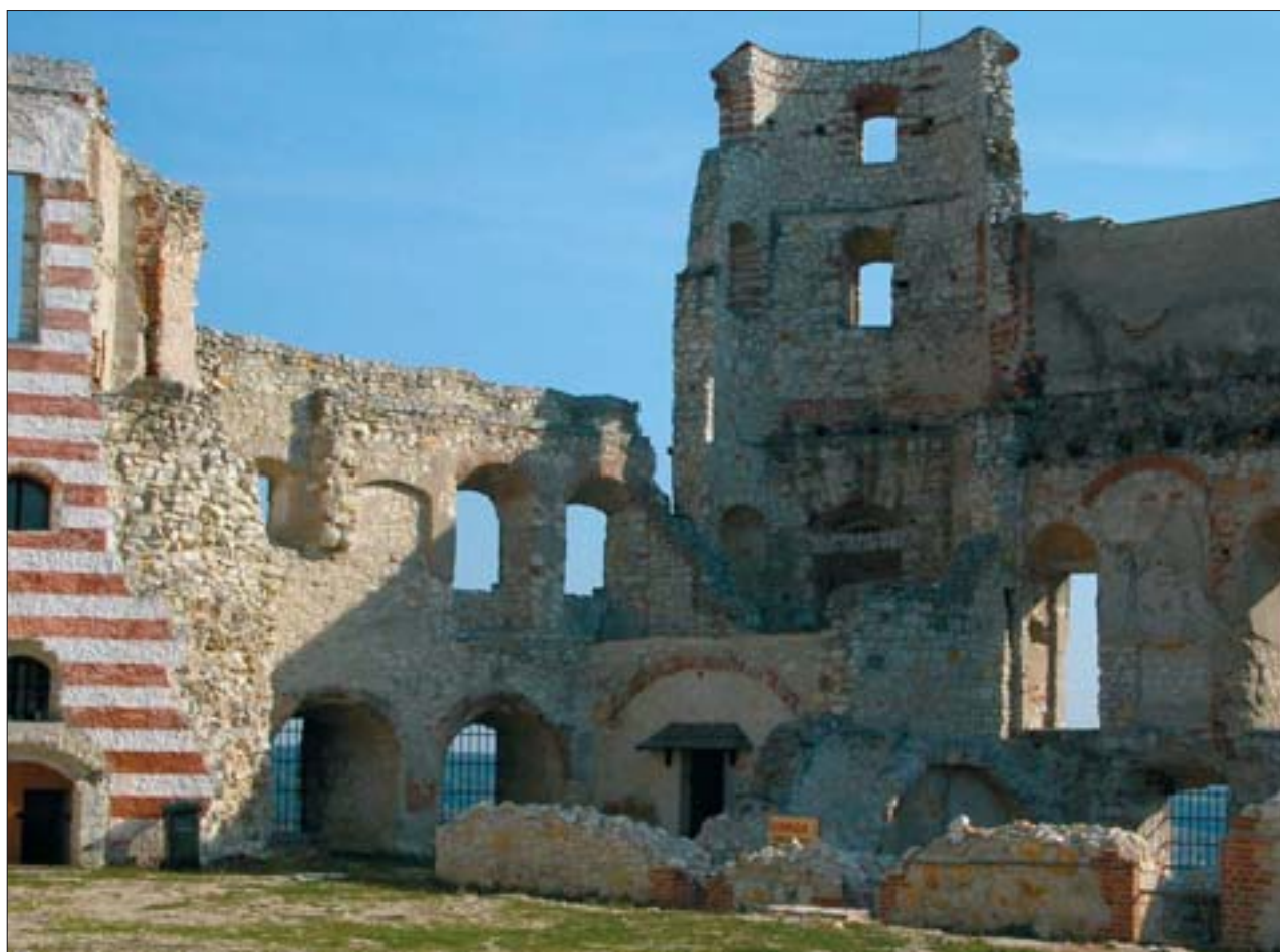
24. Widok na wieżę wschodnią od strony Dziedzińca Wielkiego. Fot. W. Santarek, 2003. 24. View of the eastern tower from the Grand Courtyard. Photo: W. Santarek, 2003.
