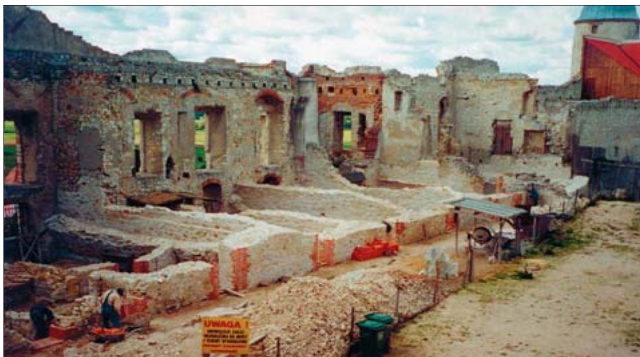
27. Amfilada południowa w trakcie prac konserwatorskich. Fot. T. Żurawski, 2000. 27. Southern suite of rooms in the course of conservation. Photo: T. Żurawski, 2000.
