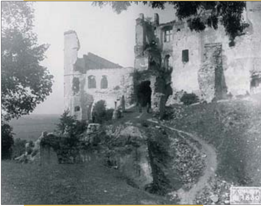
17. Widok zamku od strony wschodniej (wjazdowej). W fosie widoczne ruiny kaponiery. Fot. K. Stefański, ok. 1900. Ze zbiorów IS PAN.
