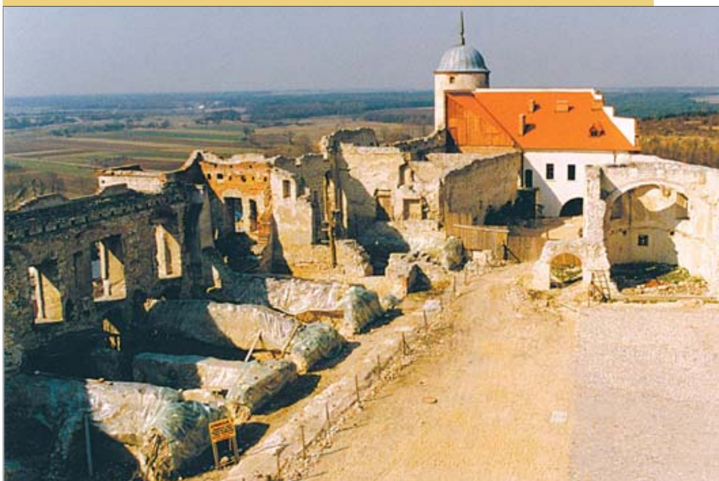
26. Amfilada południowa w trakcie prac konserwatorskich. Fot. T. Żurawski, 2000. 26. Southern suite of rooms in the course of conservation. Photo: T. Żurawski, 2000.
