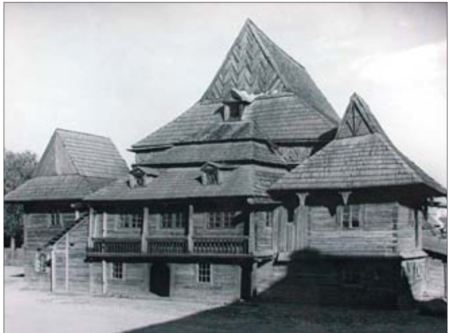
1. Widok ogólny synagogi w Zabłudowie – zdjęcie archiwalne ze zbiorów Żydowskiego Instytutu Historycznego w Warszawie.
