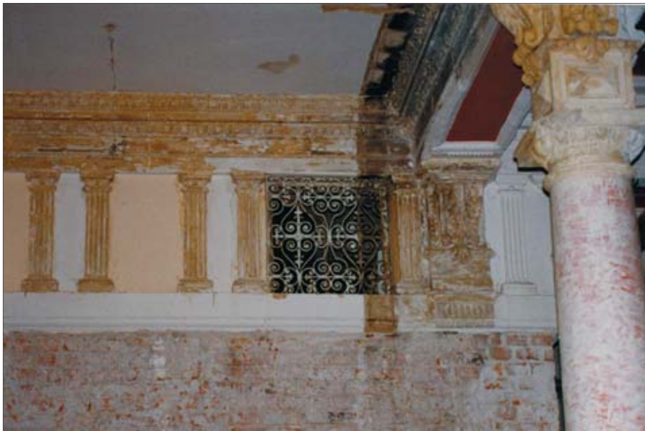
13. Zakratowane okienko w górnej części sali operacyjnej, odsłonięte w 1995 r. w wyniku badań przeprowadzonych przez autorki artykułu. Dawniej umożliwiała ukrytym w pomieszczeniu na półpiętrze strażnikom obserwowanie przebywających na sali interesantów.
