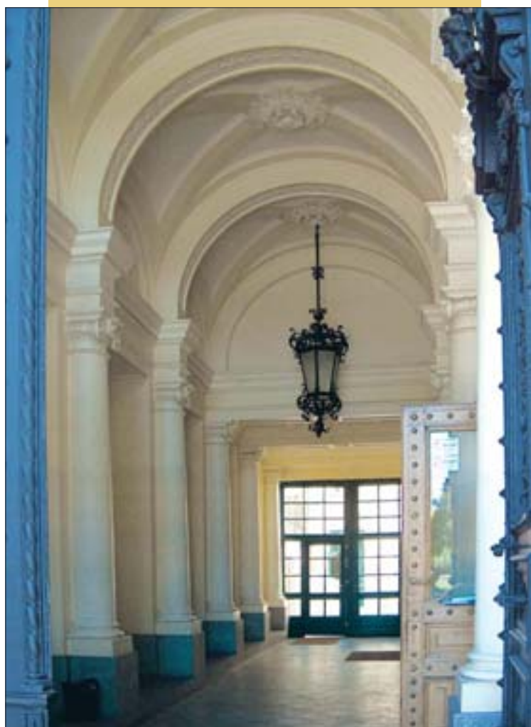
8. Przejazd bramny – widok od strony podwórza. Stan obecny.
