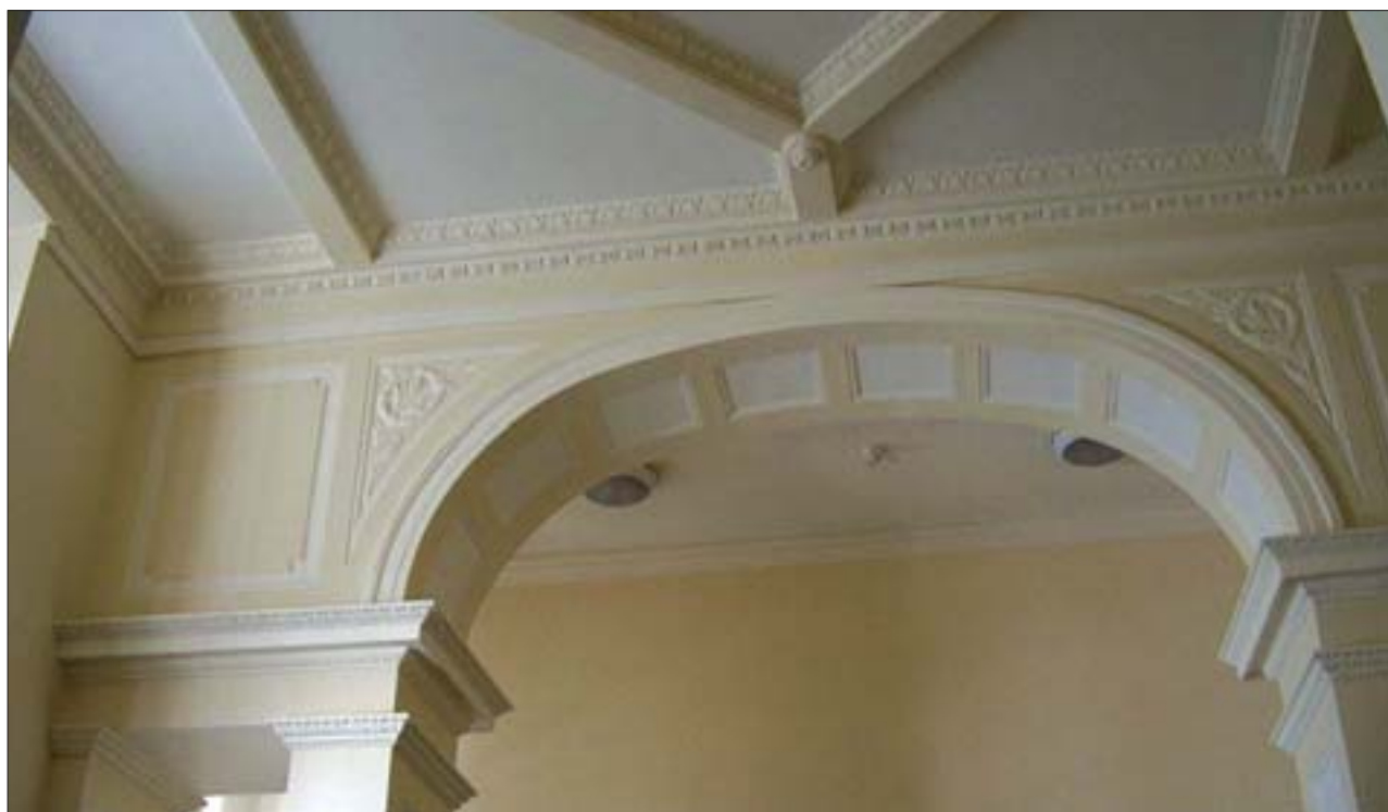
12. Dekoracja sztukatorska sali z serlianą (na parterze budynku). Stan z 1995 r. 12. Stucco decoration of the room with the serliana (ground floor). State in 1995.
