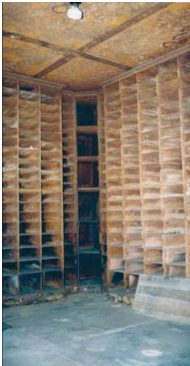
5. Metalowe skrytki na kasety z kosztownościami w pomieszczeniu skarbcza głównego. Stan w 1995 r.
