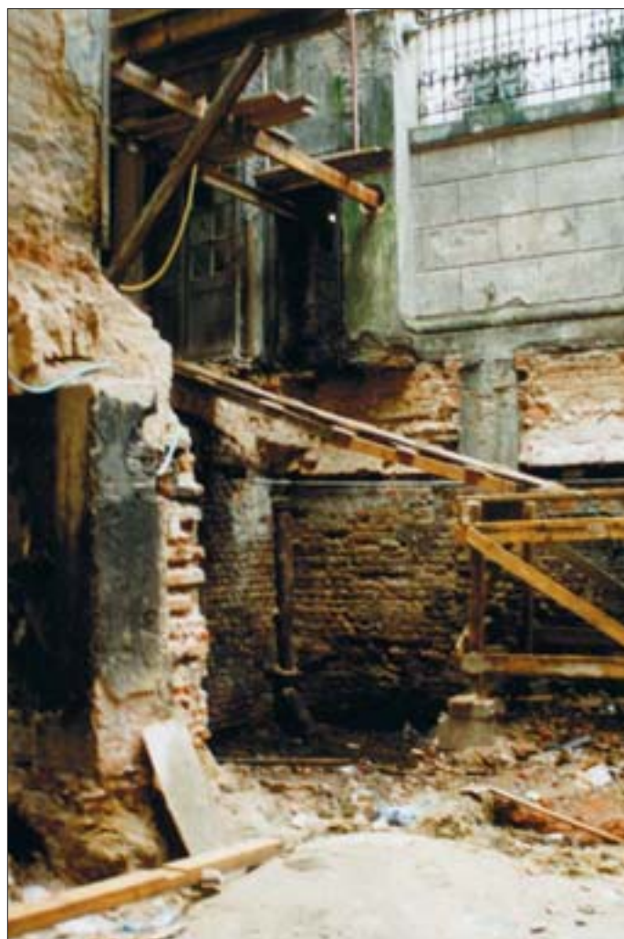
4. Widok piwnic znajdujących się pod powierzchnią podwórza podczas prac remontowo-modernizacyjnych w 1995 r. 4. Views of cellars below the surface of the courtyard during repair-modernisation in 1995.
