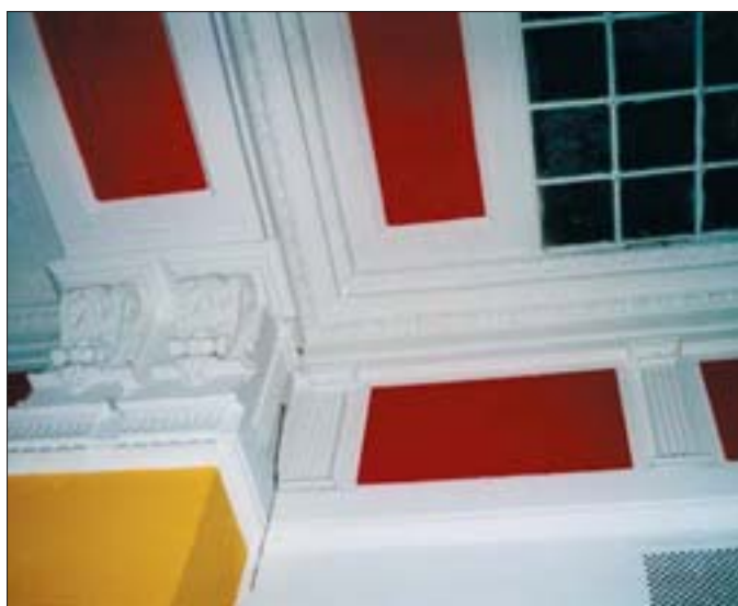
11. Fragmenty kasetonowego stropu dawnej sali operacyjnej. Stan przed pracami konserwatorskimi. 11. Fragments of the coffer ceiling of the former bank hall. State prior to conservation.
